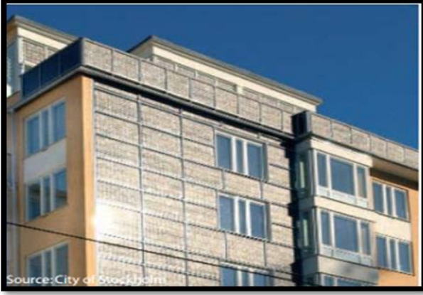
الشكل رقم 37 : صورة توضح الخلايا الكهروضوئية المصدر: Hammarby Sjostad Case Study
