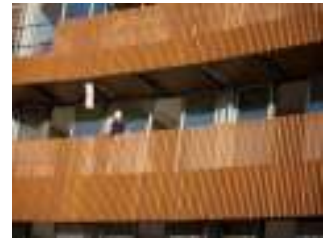
Figure 37 : les différents matériaux utilisés dans la station thermale d'Eskisehir
