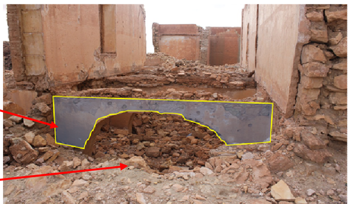
Figure 96 : Le niveau RDC effondré sous les décombres
