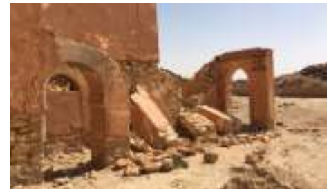
Figure 98 : La démolition des arcades
