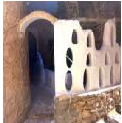
Figure 24 : Entrée d'une maison crépie en chaux. Source : revue vies de villes
