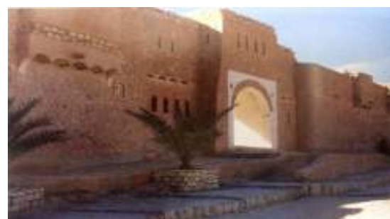
Figure 17 : Une des entrées du k'sar. Source : revue vies de villes
