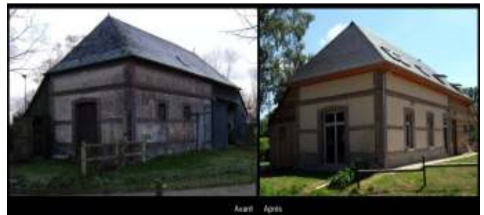
Figure 5 : Réhabilitation d'un bâtiment agricole en chambres d'hôtes
