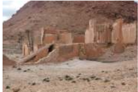
Figure 78 : la dégradation totale des toits du palais
