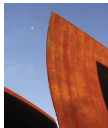
Figure 109 : La formation de la couche de rouille commence après quelques semaines.
