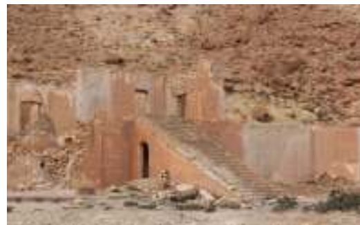
Figure 80 : L'effondrement des toits
