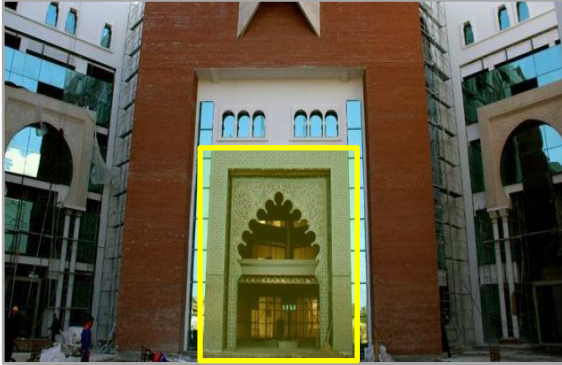
FIG. I(14) : ENTREE PRINCIPALE. SOURCE ARPC
