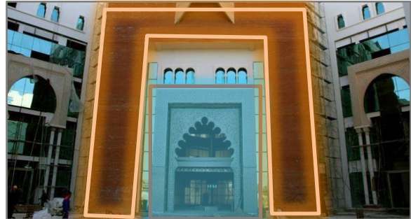
FIG. I(19) : PHOTO REPRESENTE UTILISATION DES BRIQUE PLEIN ET ZELIDJE. SOURCE ARPC
