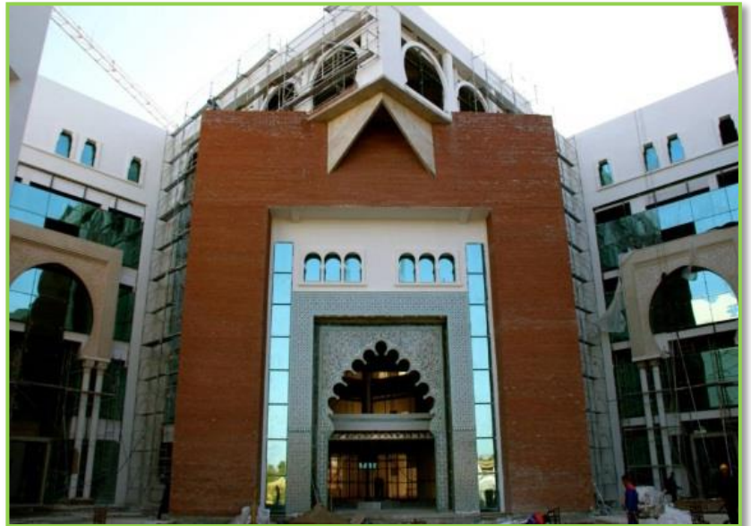
FIG. I (07): PHOTO SUR ENTREE DU CENTRE. SOURCE ARPC
