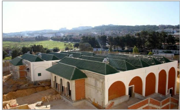
FIG. I(16) : VUE EXTERIEURE SUR L'AMPHE. SOURCE ARPC
