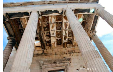
Figure 14 : Le plafond à caissons.
