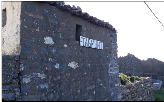
Figure 74 : mur extérieure revêt d'un Crépissage au ciment
