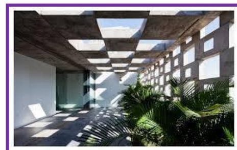
éclairage latéral et zénithal
