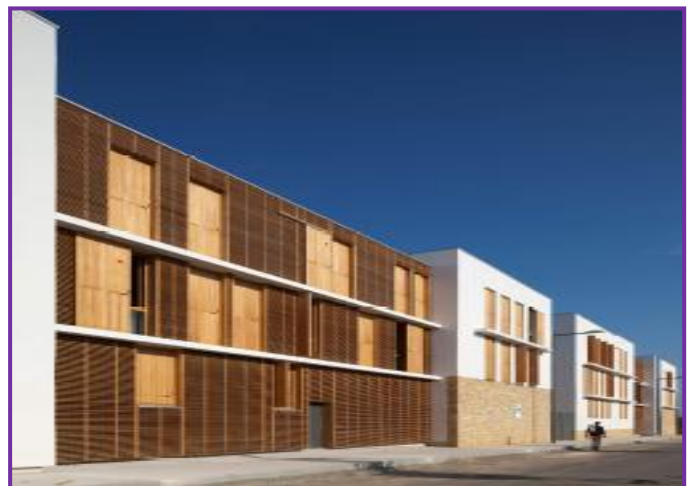
FIGI.04 : Protection solaire Lycée Kyoto. www.lycee-
