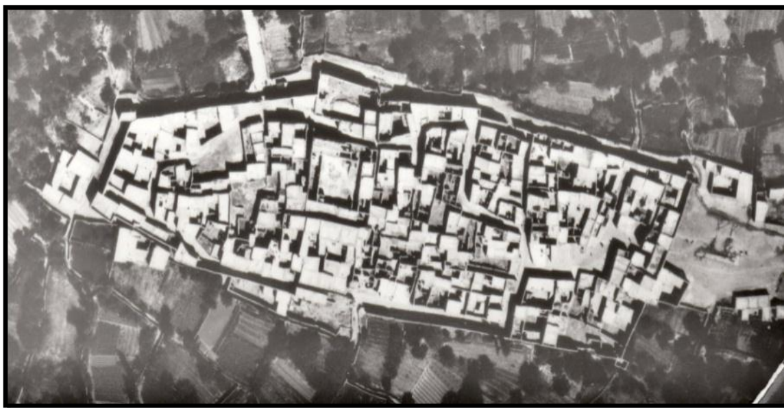
Fig. 28 : Photo qui présenter Ksar de Taouiala.
