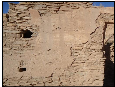
Fig. 99 : Mur en pierre enduit. Ksar Taouiala.
