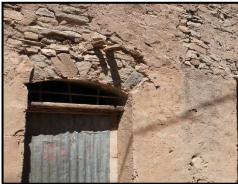
Fig. 98 : Mur en pierre enduit. Ksar Taouiala.
