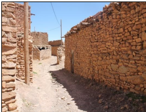
Fig. 65: Rue de ksar taouiala.
