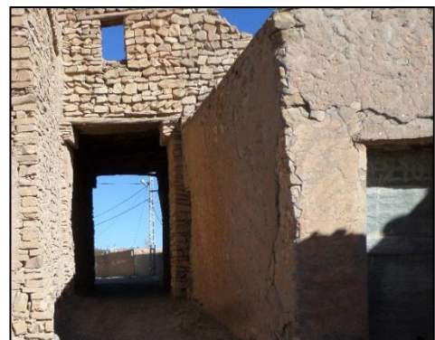
Fig. 40 : La porte d'ouest du Ksar.
