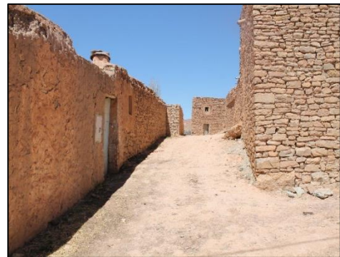
Fig. 66: Rue de ksar taouiala.
