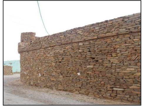
Fig. 38 : Rempart du Ksar.
