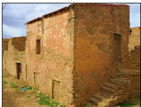
Fig. 89 : Escalier à l'extérieur.
