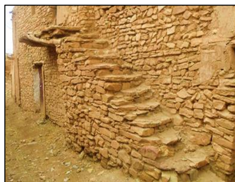
Fig. 90 : Escalier à l'extérieur.
