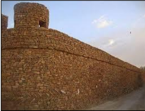
Fig. 37 : Rempart du Ksar.
