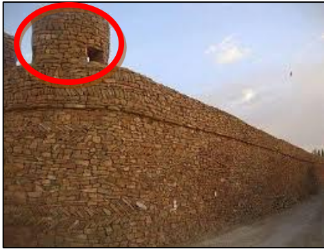
Fig. 45 : La Tour du côté nord-est du Ksar.
