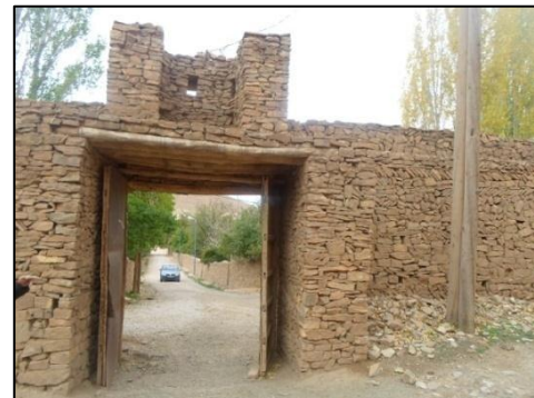
Fig. 44 : La porte nord vers l'extérieur du Ksar.
