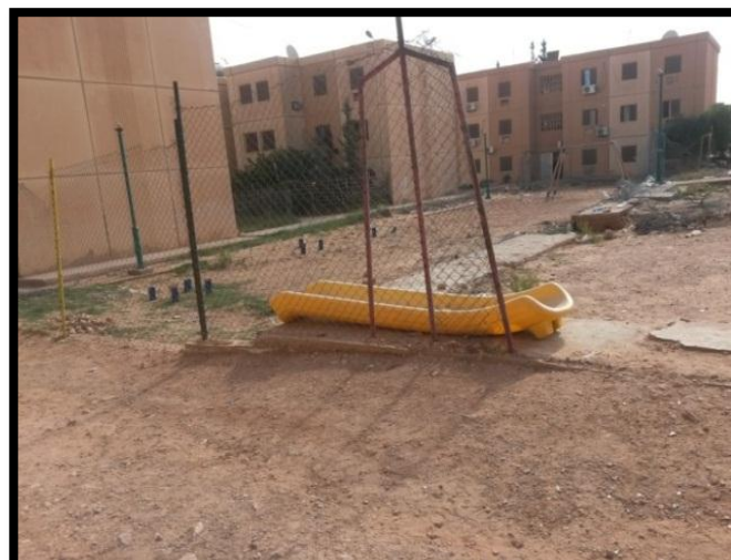
Photo 37: la dégradation des air de jeux Source : auteur
