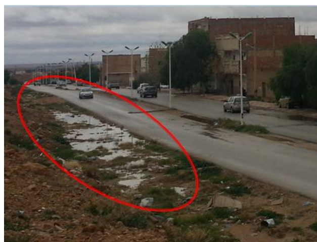
Photo 26: les eaux pluviales dans la ville de Laghouat Source : auteur
