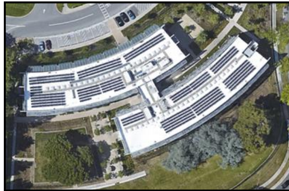
Figure 29 : Les Panneaux solaires sur la toiture de la Naza Source :(Programme : Google eurth.com)
