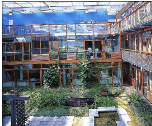
Figure 10 : vue de l'intérieur du projet
