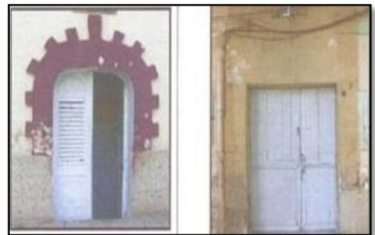
Figure 12 : Traitement de portes traditionnelles.
