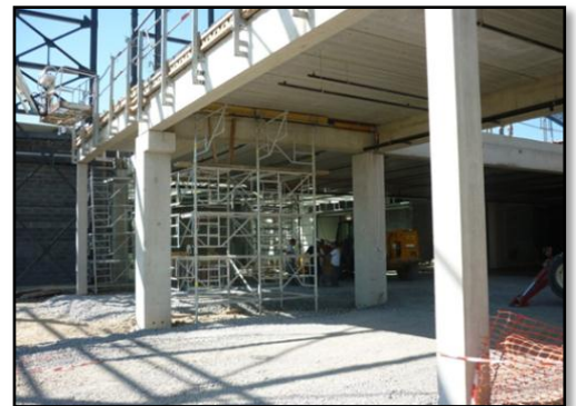
Figure 105 : La structure (Poteaux, Poutre). Source : www.mpi.fr
