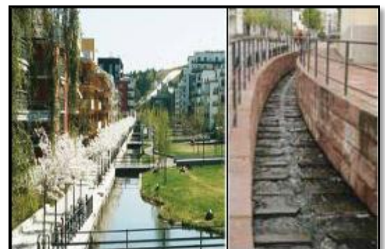
Figure 52 : Traitement des eaux usées du quartier.
