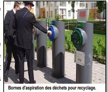
Figure 53 : Les bornes d'aspiration des déchets.
