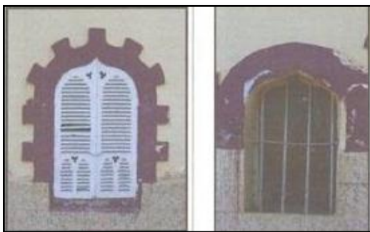
Figure 11 : Traitement de fenêtres traditionnelles.
