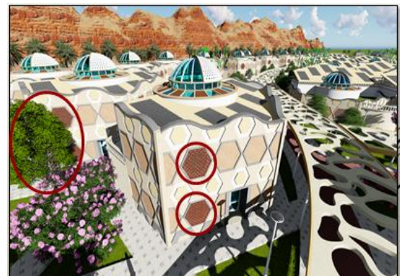
Figure 135 : Les protections solaires au niveau de logements.
