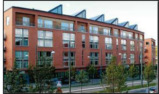
Figure 49 : les panneaux photovoltaïques sur les toits.
