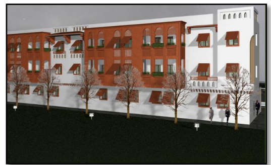
Figure 23 : Façade sur l'extérieur de projet. Source : OPGI de wilaya de Laghouat
