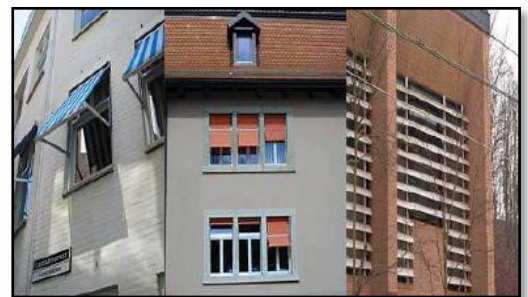
Figure 121 : Les protections solaires extérieures mobiles.
