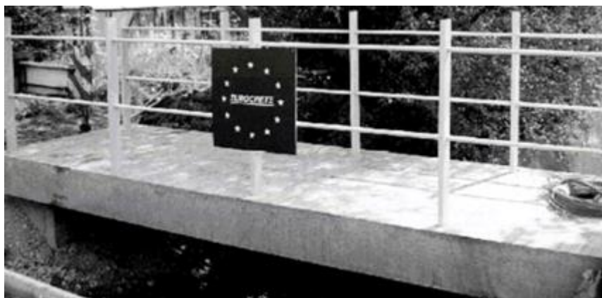
Figure 2.27 : Première passerelle en béton renforcé complètement en PRF en Europe (Eurocrete project)
