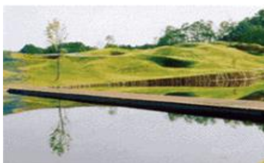
Figure 2.24 : Utilisation des tendons en PRF dans le pont Pontoon au “ Takahiko three country club ”, Japon
