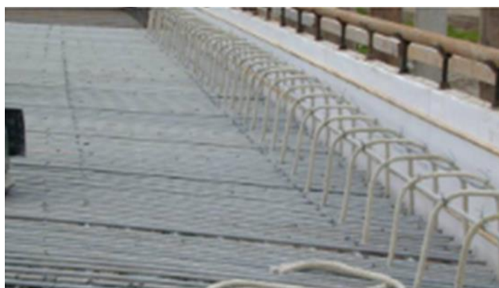
Figure 2.35 : Tablier de pont en PRFV, Wotton , Québec
