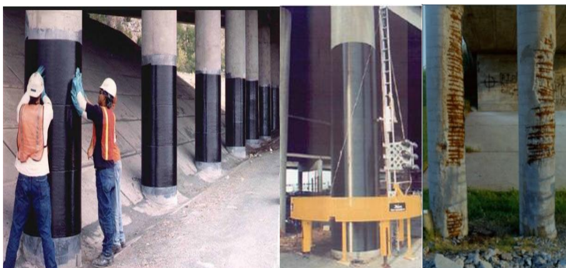
Figure 2.22 : Réhabilitation et renforcement des colonnes d'un pont en utilisant une enveloppe en fibres de Carbone.
