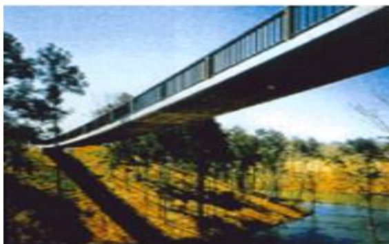
Figure 2.26 : Utilisation des barres de PRFC dans le pont de Ribbon au sonthern yard country club , Japon.
