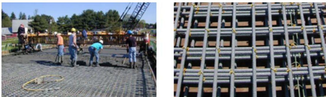
Figure 2.30 : Tablier de pont en PRFV, Morristown - Vermont (USA)
