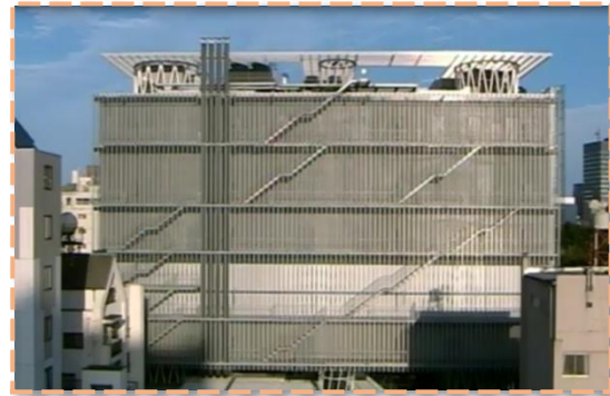
Figure 52 Façade Ouest Source : http://www.archdaily.com
