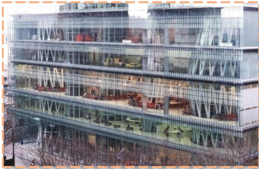
Figure 51 Façade Nord Source : http://www.archdaily.com
