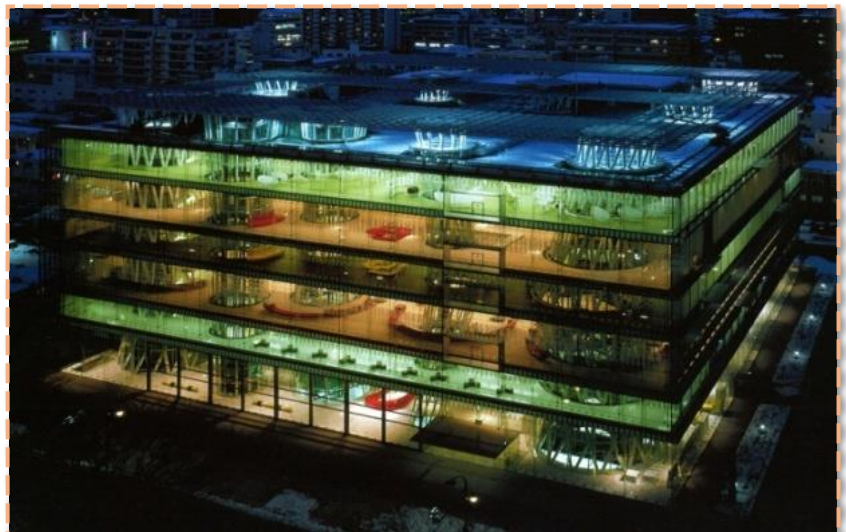
Figure 25 : Vue sur la médiathèque de Sendai Source: http://4.bp.blogspot.com/07a .
