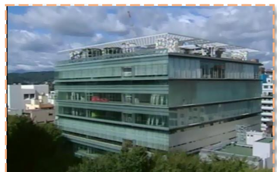
Figure 50 : Façade Sud et Est Source : http://www.archdaily.com
