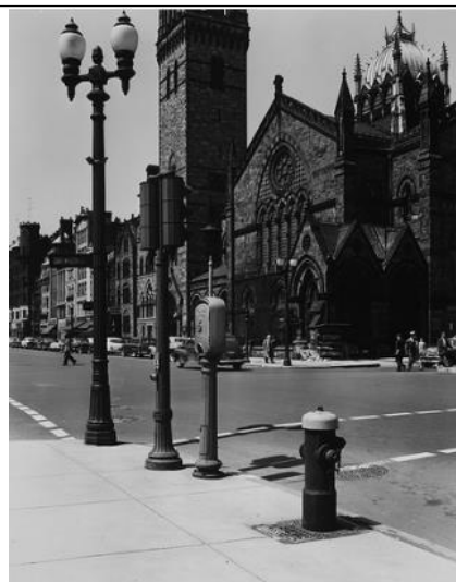
الصورة 55: وحدات إضاءة (كلاسيكية)
