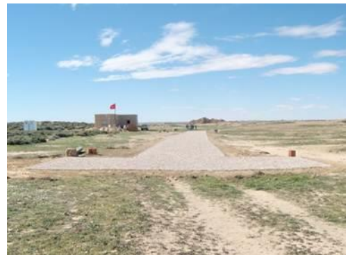
الصورة 19: تهيئة مدخل الموقع
