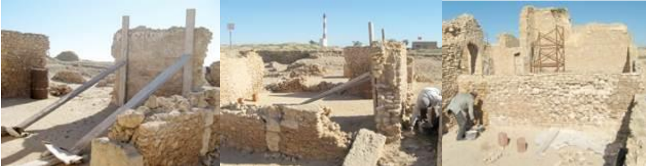
الصورة 18: تثبيت وتقوية الجدران
