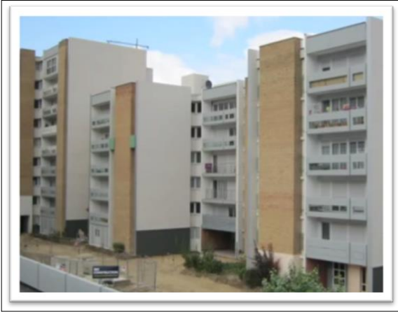
صورة رقم 07: توضح إعادة تأهيل الواجهات في الحي .
