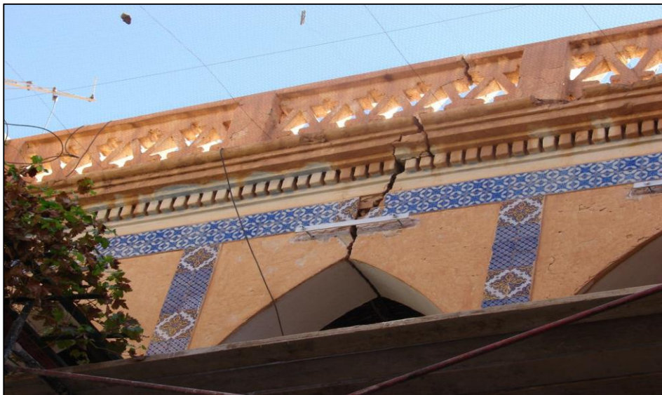
Figure III.2. Fissure profonde.
