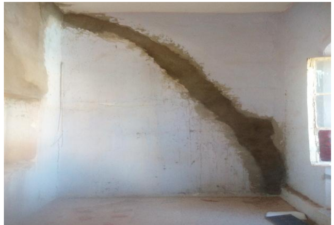
Figure III.21. Fissure profonde réparée.
