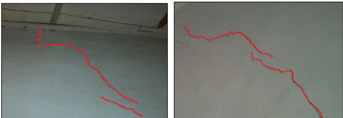
Figure III.8. Fissure superficielle.
