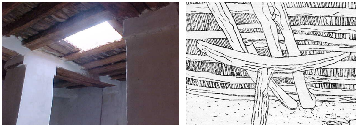
Figure I.15 : Les toits ( Ayn-ad-dâr (« œil de la maison » à Taghit (2003) [16]
