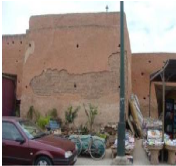
Figure II.3 : Décollement d'enduits [2]
