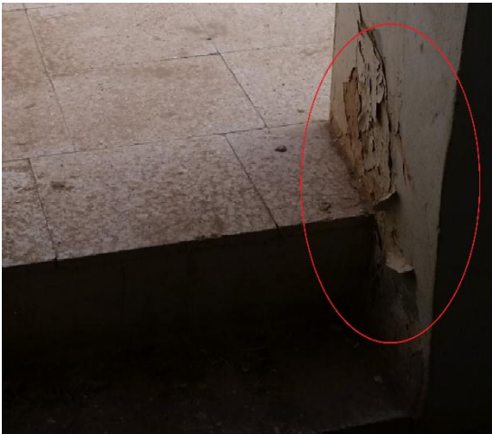
Figure III.9. Fissure profonde
