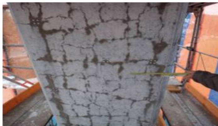
Figure 1.3 : épaufrures dues à l'alcali-réaction [14].
