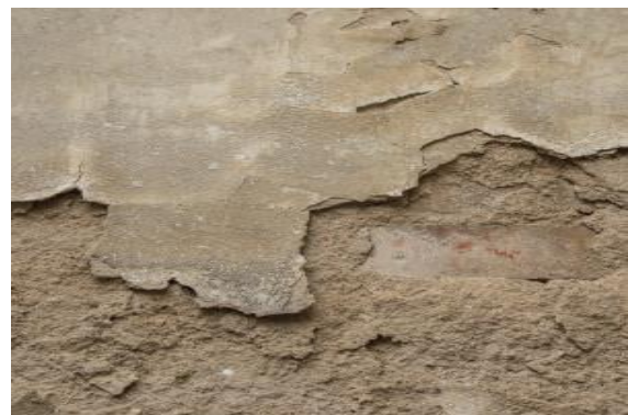
Figure 1.6 : Dégradation d'un ouvrage soumis au gel dégel.
