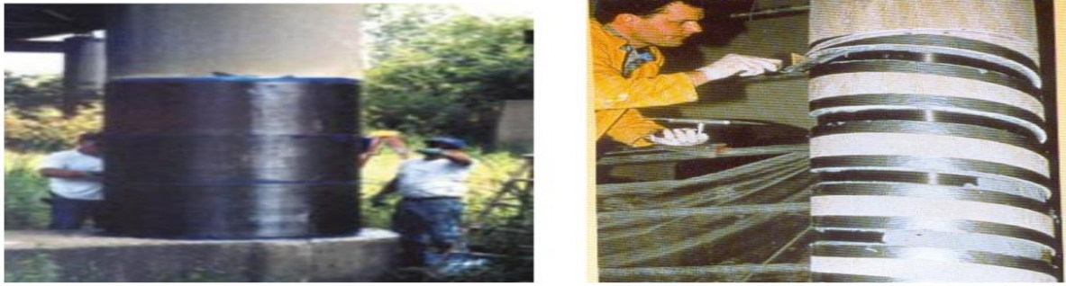
Figure 1.14 : confinement des poteaux par stratification directe [29].
