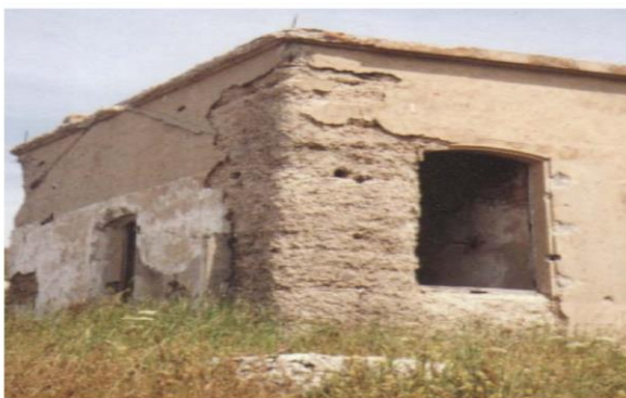
Figure 1.6 : Dégradation d'un ouvrage soumis au gel dégel.
