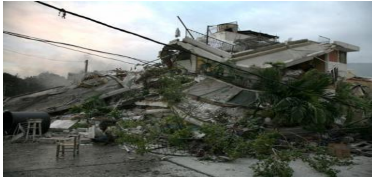
Figure 1.5 : Effet de séisme [18].
