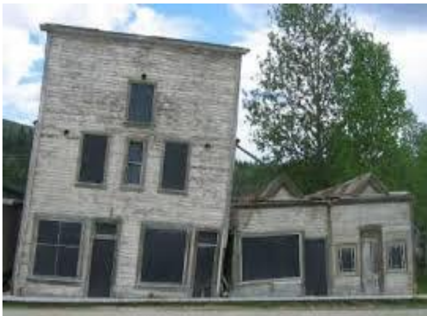
Figure 1.4 : tassement différentiel [14].
