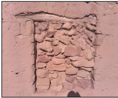
Figure 177:fenêtre fermé par des blocs de pierre- Source : Auteur
