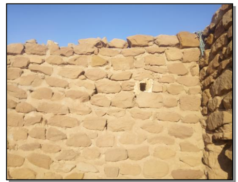
Figure 205: Utilisation de la pierre au niveau des murs intérieurs ; Source : Auteur
