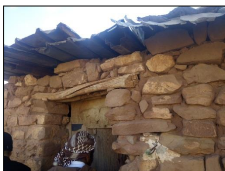
Figure 207: l'utilisation des bois dans les linteaux de portes- Source : Auteur
