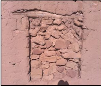
Changement de plusieurs ouvertures par des blocs en pierre
