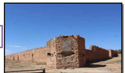
Figure 199:Tour 01- Source Auteur
