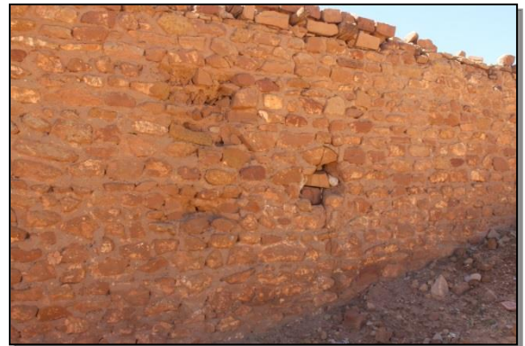
Figure 212: mur extérieur –Source : auteur
