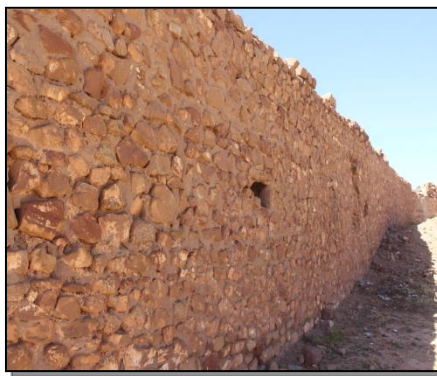
Figure 203: Utilisation de la pierre au niveau des murs extérieurs, Source : Auteur
