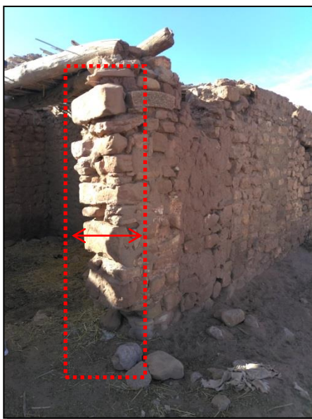
Figure 214: Epaisseur des murs intérieurs 40 cm-source : auteur
