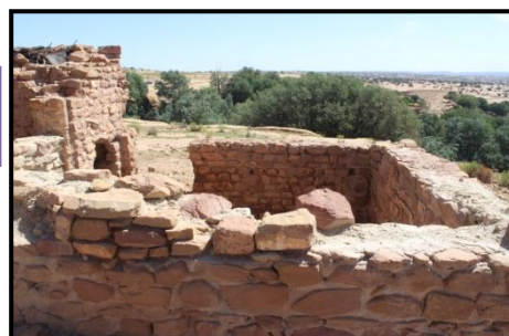
Figure 201 : Tour 02- Source : Auteur
