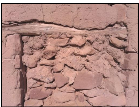
Figure 208: l'utilisation des bois dans les linteaux de fenêtres- Source : Auteur
