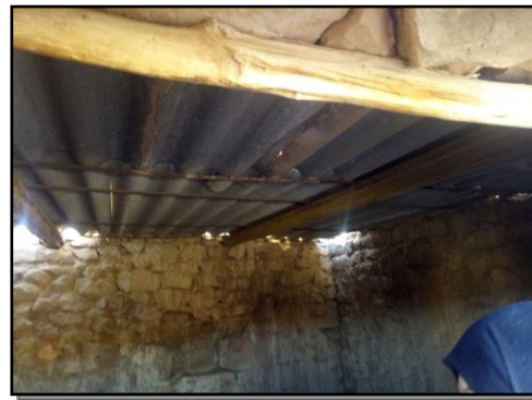
Figure 173: le plancher fait par les habitants du village (Métal et fer)- Source : Auteur
