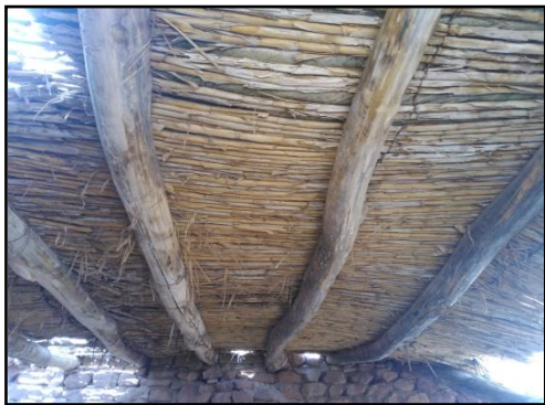
Figure 174: Le plancher original du monument - Troncs d'arbres et roseau- Source : Auteur
