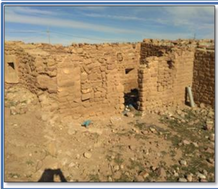
Démolition des parties du bâti
