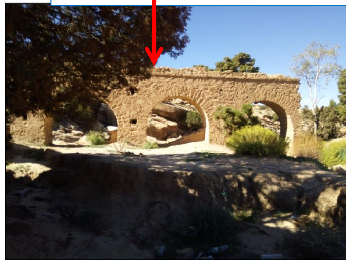
Figure 139: les aqueducs du moulin - source: Auteur
