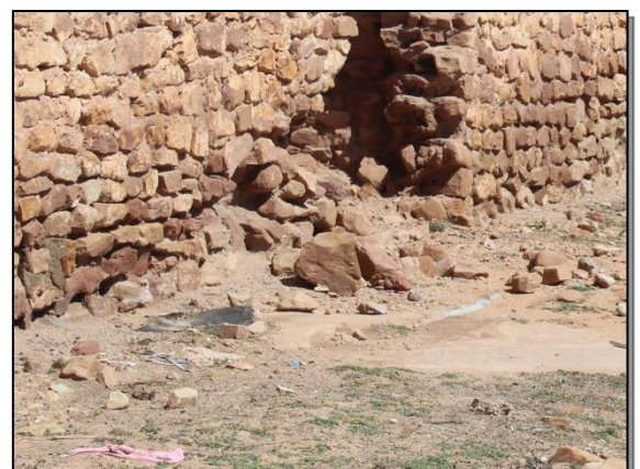
Figure 210: la construction des murs directement sur la roche. Source : auteur
