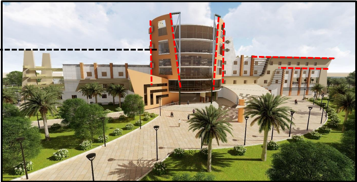
Fig166 : les éléments architectoniques de façade principale / source : Auteur
