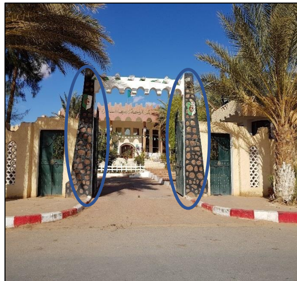
Fig79 : les corniches coniques Source auteur
