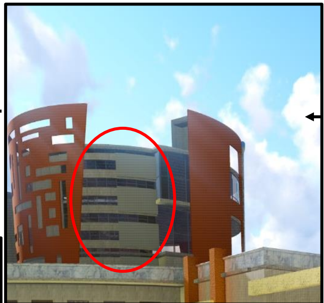
Fig179 : les brises soleil horizontaux sur l'élément central source : Auteur
