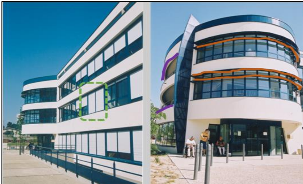
Fig26 : vue sur façade principale côté sud Source : www.cos-asso.org
