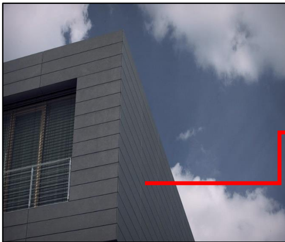
Fig :46 : bardage en pvc (centre de Réhazenter) Source : http://archiduc.lu
