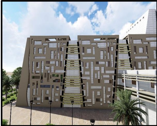
Fig183 : façade postérieure source : Auteur
