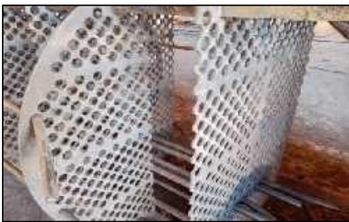
Figure I.15 : extraction des anciens tubes du faisceau tubulaire
