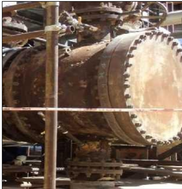
Figure I.5 : La boîte de distribution de l'échangeur.
