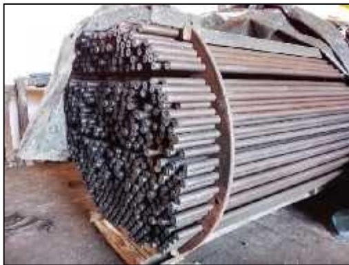
Figure I.16 : insertion des nouveaux tubes
