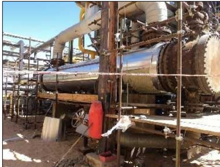
Figure I.3 : L'échangeur de chaleur
