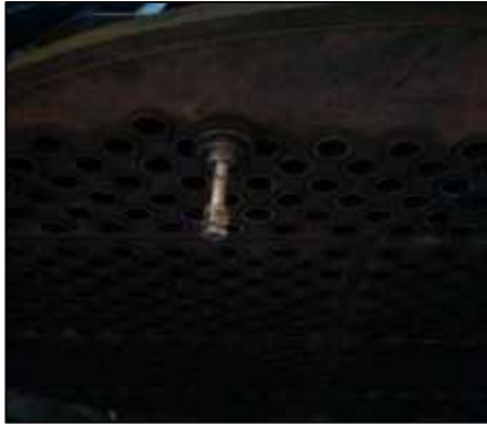
Figure I.17 : dudgeonnage des tubes
