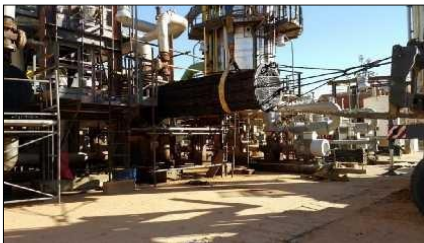
Figure I.13 : Extraction du faisceau tubulaire en utilisant l'extracteur hydraulique désigné spécialement pour l'extraction des faisceaux tubulaire, avec une grue de 60 tonnes.
