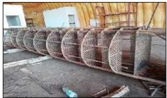
Figure I.15 : extraction des anciens tubes du faisceau tubulaire
