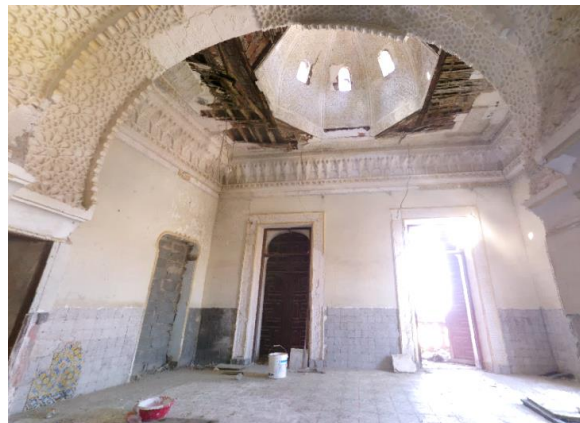
Figure 72: Décollement d'une partie de revêtement d'un mur, source : scanner BLK360 Sahli
