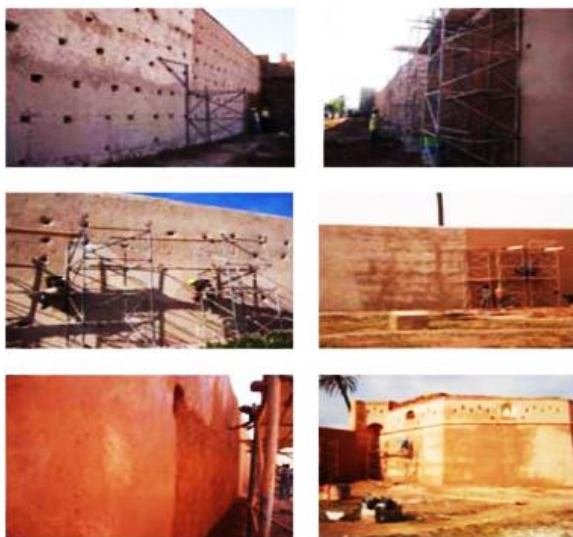
Figure 14: travaux d'enduit, Source : la restauration de muraille de Marrakech
