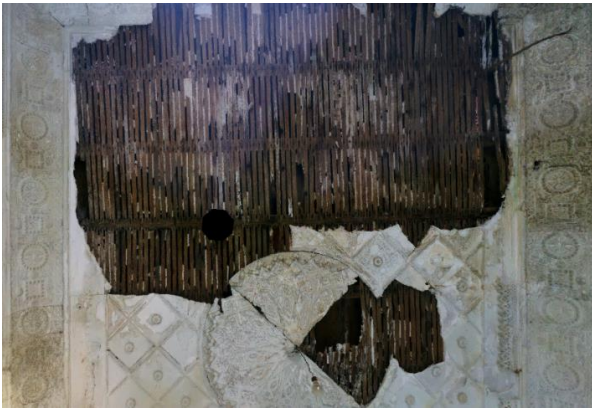
Figure 49 : plancher en bois du Palais des Aveugles, source : scanner BLK360 Sahli
