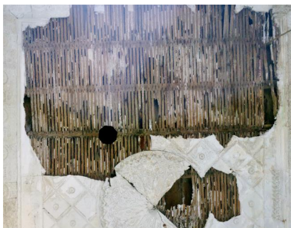
Figure 76 : Cassures des éléments en bois, source : scanner BLK360 Sahli
