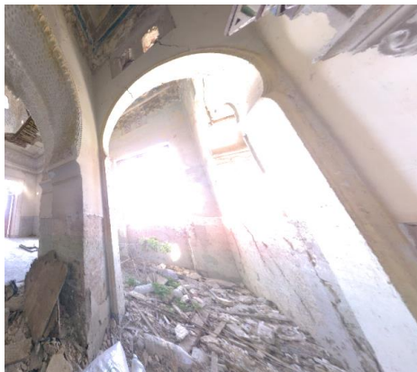
Figure 72: Décollement d'une partie de revêtement d'un mur, source : scanner BLK360 Sahli
