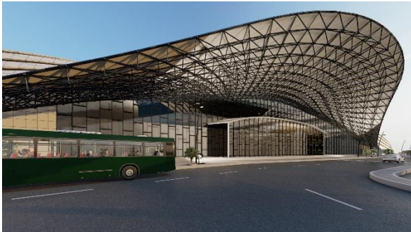
FIGURE 01 : LA TOITURE METALLIQUE TRIDIMENSIONNELLE.
