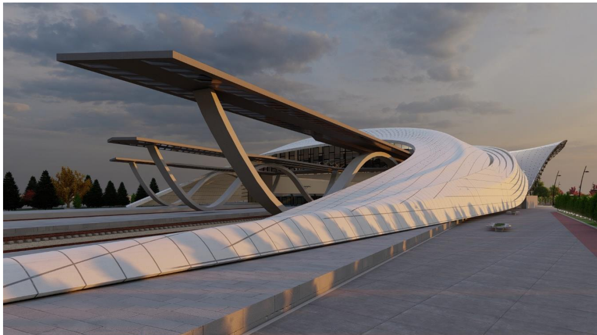
FIGURE 38 :LA FAÇADE LATERALE SUD-OUEST.
