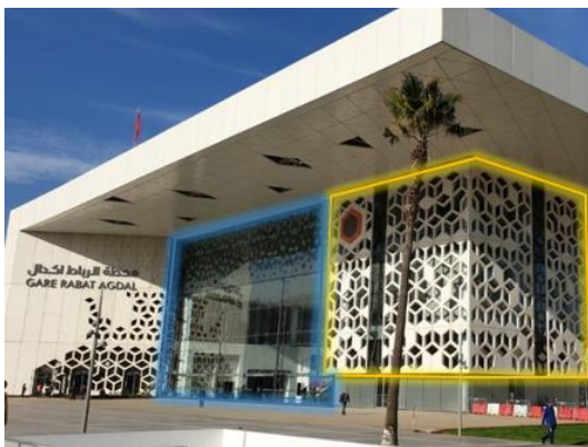
FIGURE 39:LA FAÇADE SUD EST.
