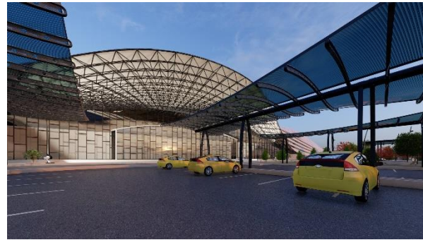
FIGURE 14:DES PANNEAUX PHOTOVOLTAÏQUES DANS L'ABRI DE PARKING.
