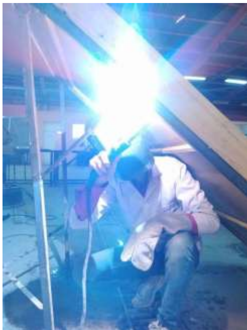
Figure II.26 : le soudage de la structure métallique
