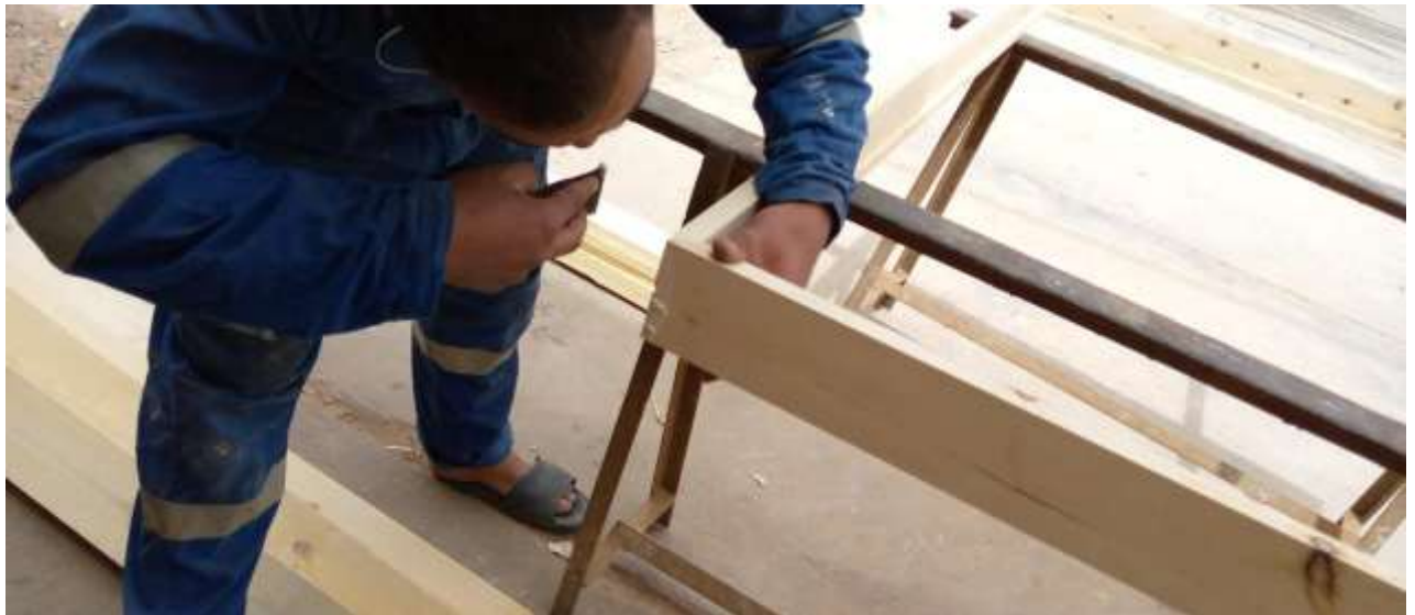
Figure II.13 : La finition de montage de cadre du panneau par l'addition du mastique sur les coins pour assurer un assemblage dure et des joins sans vide
