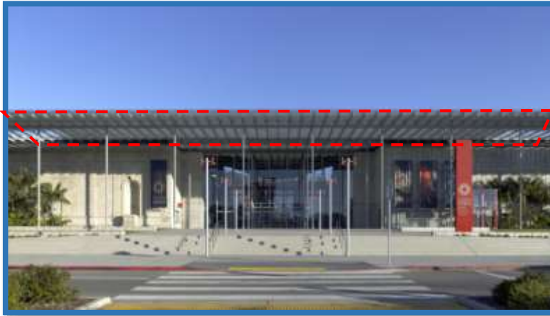
Figure I.10: la façade principale d'Académie des sciences de Californie Source : http://www.architectfuture.com
