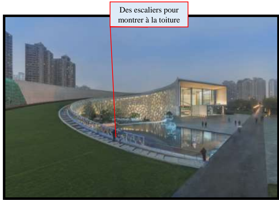
Figure I.37 : l'accès de terrasse Source : http://perkinswill.com
