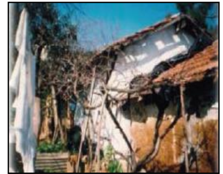
Figure 22 : Construction : mélange de dur/pisé. Source Moussannef C.
