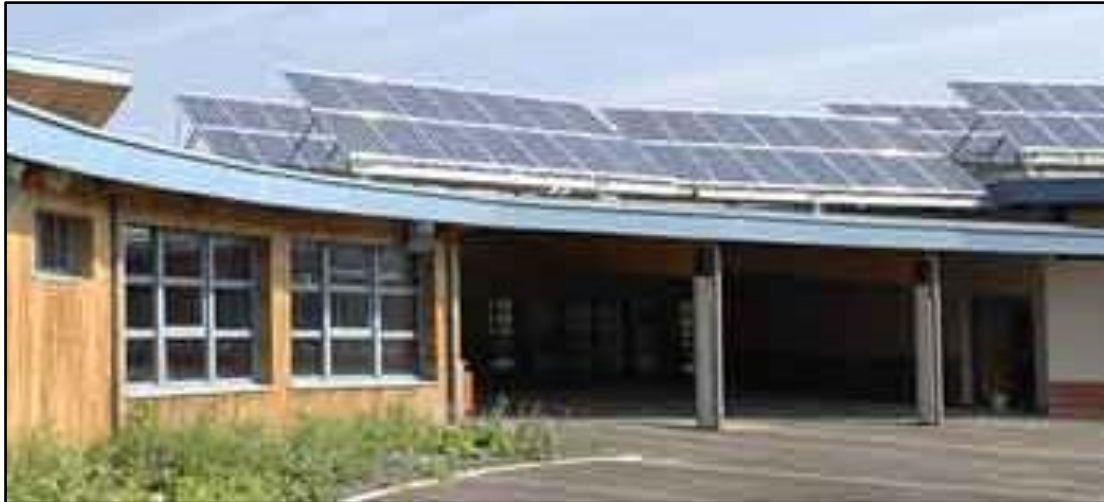
Figure I. 21 : Les panneaux solaires
