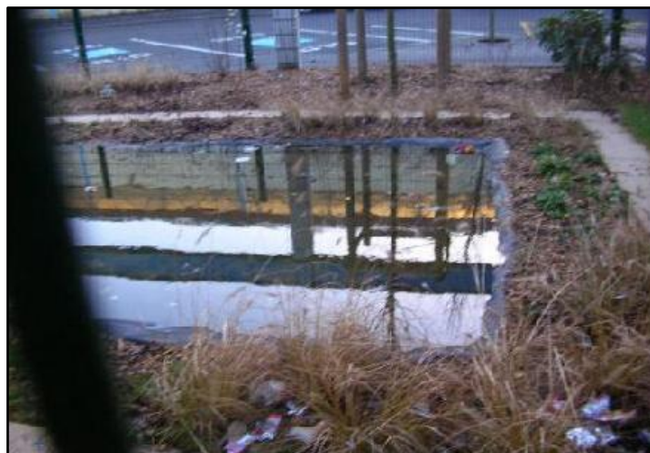
Figure I. 19 : Un bassin de rétention des eaux pluviales
