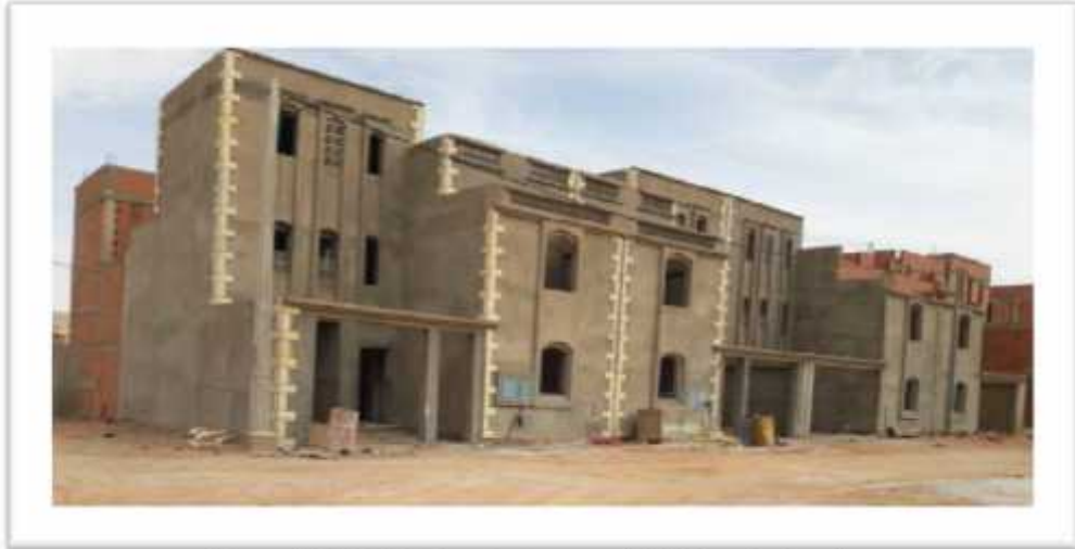
Figure 2.9 Réalisation des travaux de finition de façade
