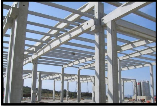
الشكل 1.V. 31 : اعمدة وعوارض مسبقة الصنع و الجهد
