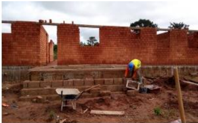
Figure V-8: Bloc de terre comprimé et stabilisé.
