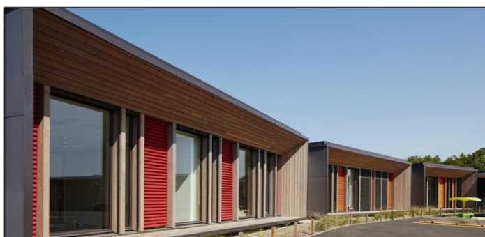
Figure I-18: Façade Sud de l'école Grézieu.
