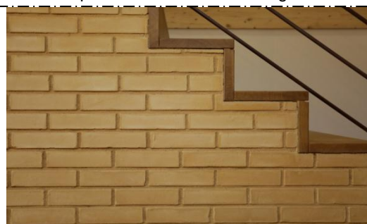
Figure V-9: Mur intérieur en BTCS.
