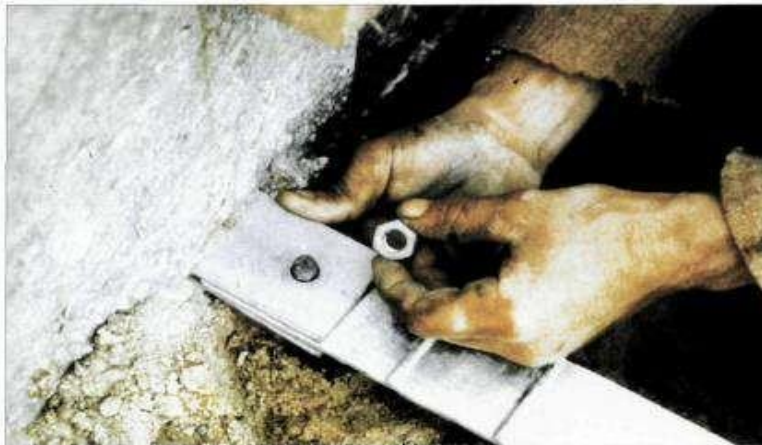
Figure I.12 : Renforcement par lanières métalliques de terre armée
