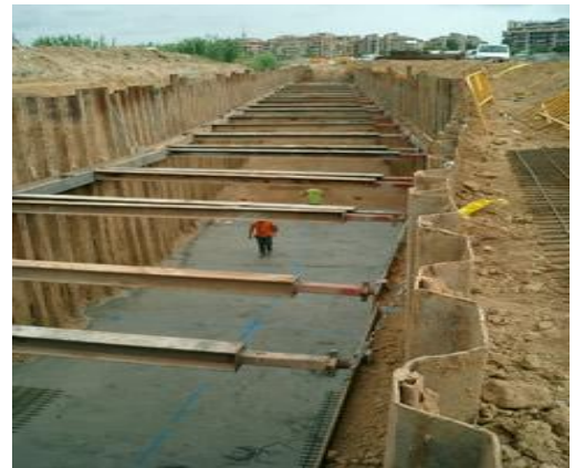
Figure I.2 : Les rideaux de palplanches métalliques
