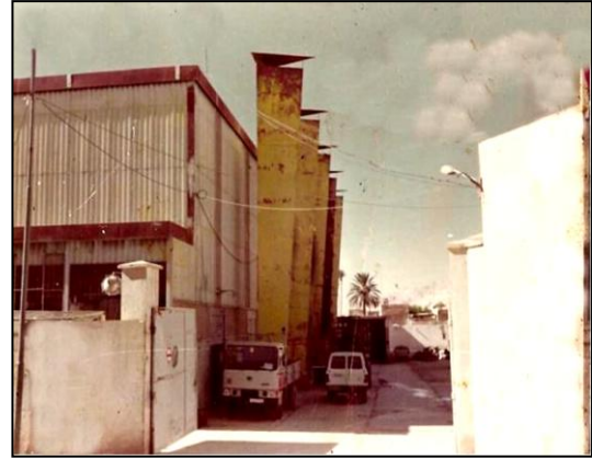
الصورة رقم 59: توضح المركز الكهربائي بحي الشطيبة
