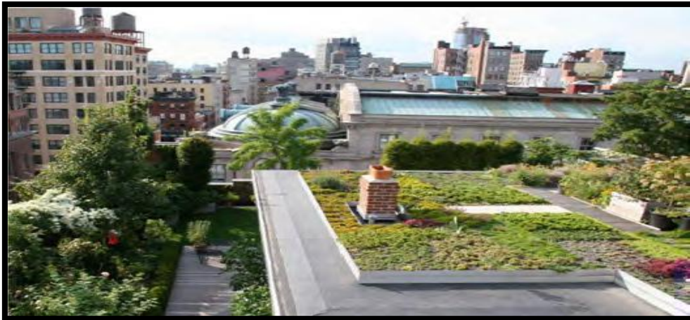
الصورة رقم 121 زراعة الاسطح واسعة النطاق في المباني السكنية المانيا المصدر : Dunnett, N. and N.
