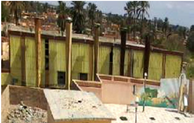
الصورة رقم 66: توضح المركز الكهربائي في حي الشطيح المصدر : من قبل الطالب
