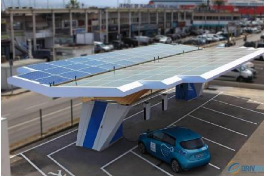
Figure III.15 : Parking de voiture électrique avec système de recharge photovoltaïque.
