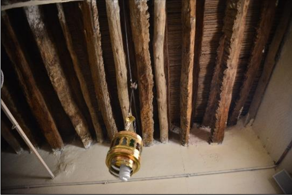
صورة -29- سقف المسجد العتيق حاليا (الباحث)
