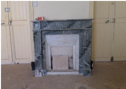
Figure 162: Cheminée 3 en marbre vert, source: auteur
