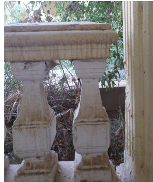
Figure 159: garde du corps au niveau de la galerie, source: auteur
