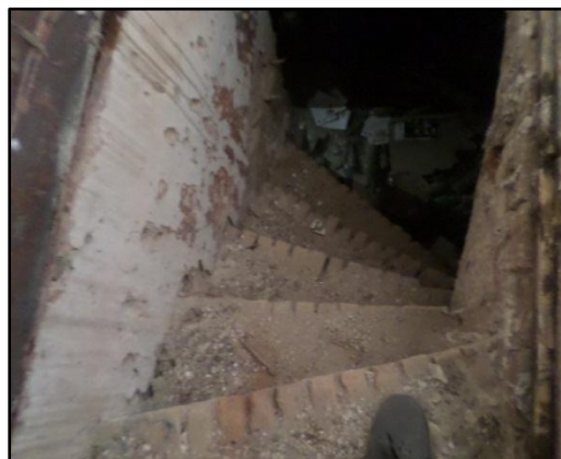
Figure 129: Escalier d'accès au sous-sol,
