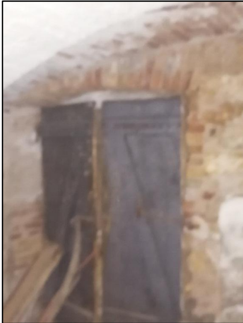
Figure 151: Porte au niveau du sous-sol qui donne directement sur la ruelle, source: auteur
