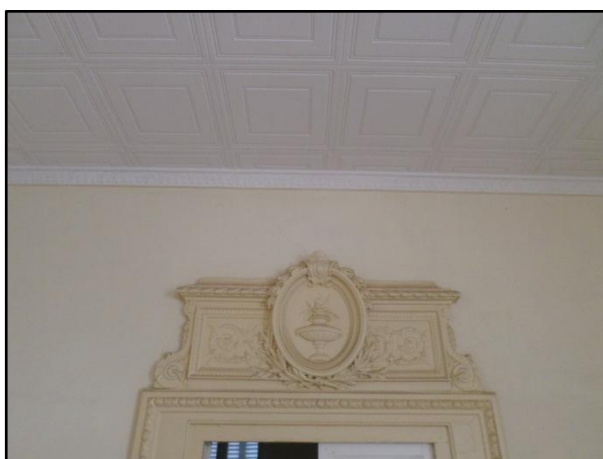
Figure 130: Faux plafond dans une des pièces de la villa de l'Orangerie, source: auteur
