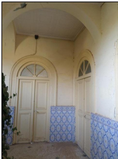
Figure 127: Faïence posée sur la partie basse des murs de la galerie, source: auteur
