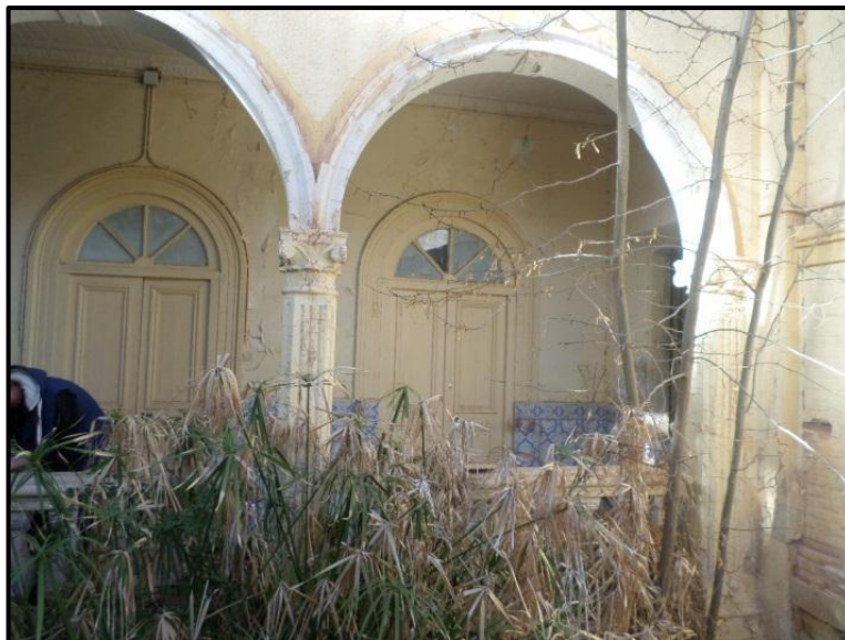
Figure 142: Arcades plein cintre, source: auteur
