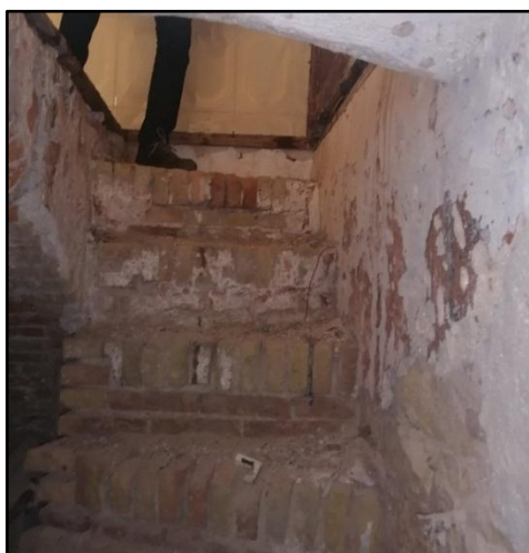
Figure 128 : Escalier d'accès au sous-sol,
