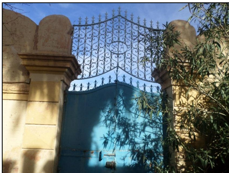
Figure 118: Prtail de l'entrée principale de la villa de l'Orangeria, source: auteur
