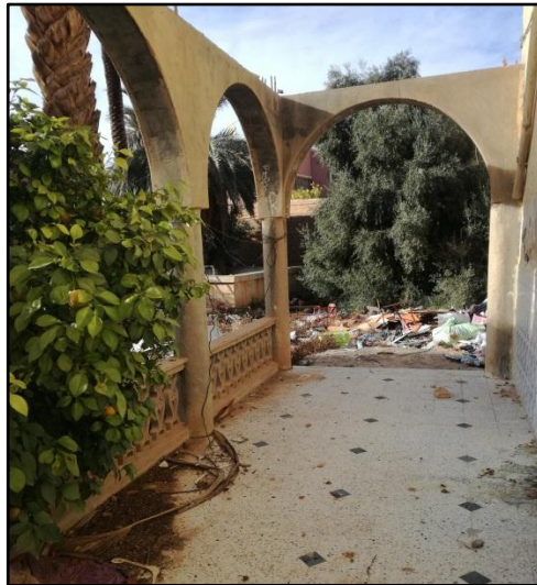
Figure 126: La véranda coté jardin, source: auteur
