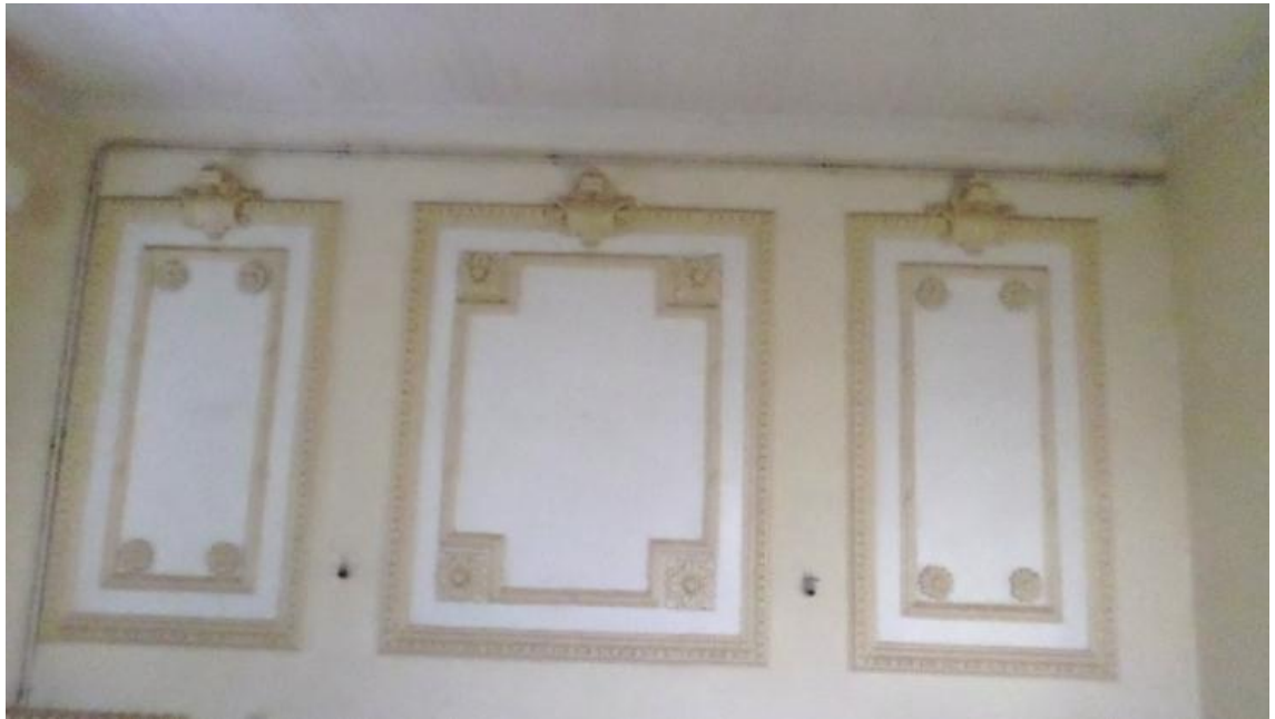
Figure 153: Panneaux de plâtre en relief, décorant les murs d'une des pièces de la villa, source: auteur
