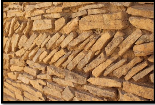
صورة (25): طريقة البناء المتخالفة للتمتين و التزيين المصدر: مديرية الثقافة بالأغواط
