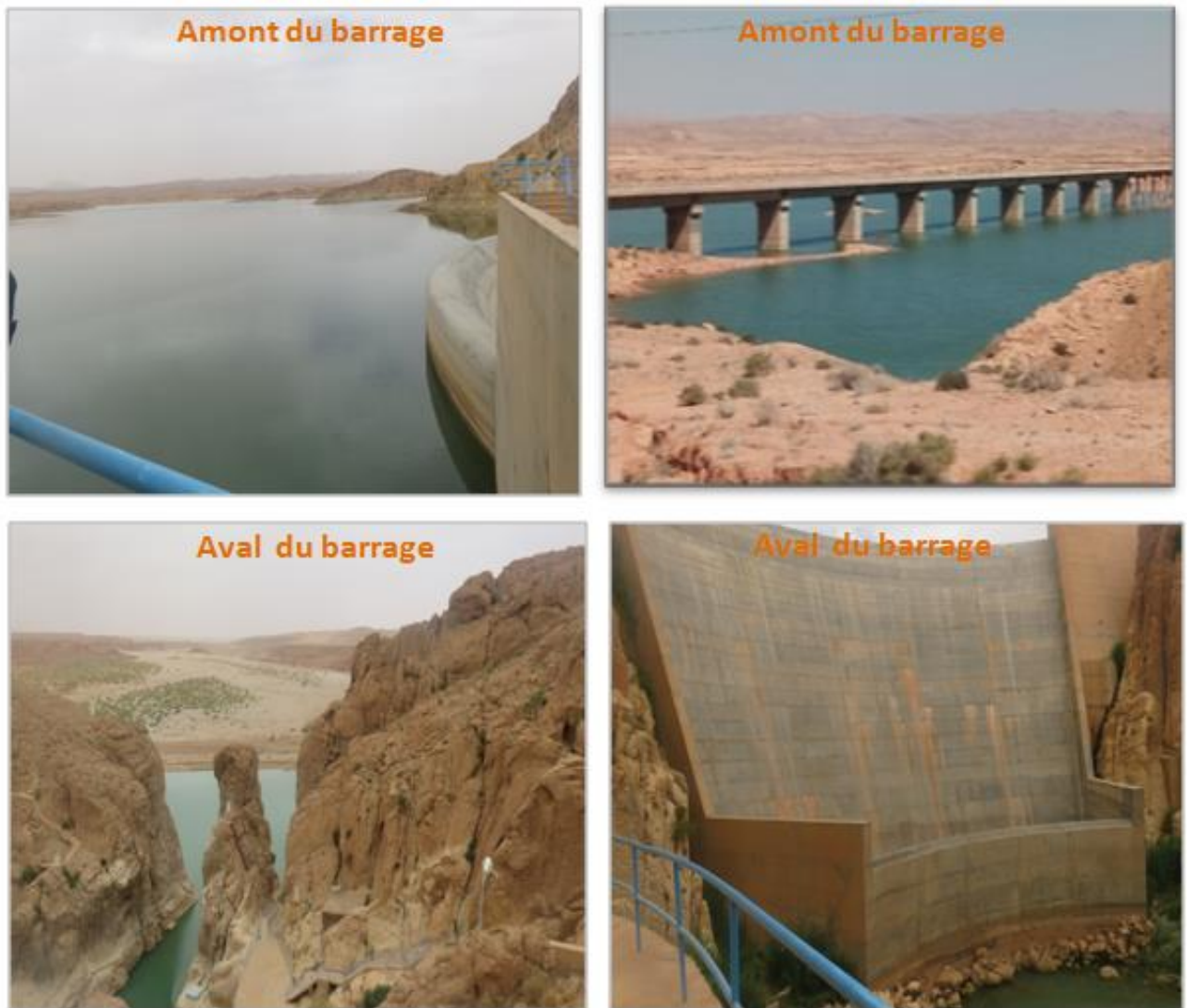
Figure 12 : Barrage de Brézina (Originale, 2017)
