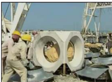
L'utilisation des blocs de béton
