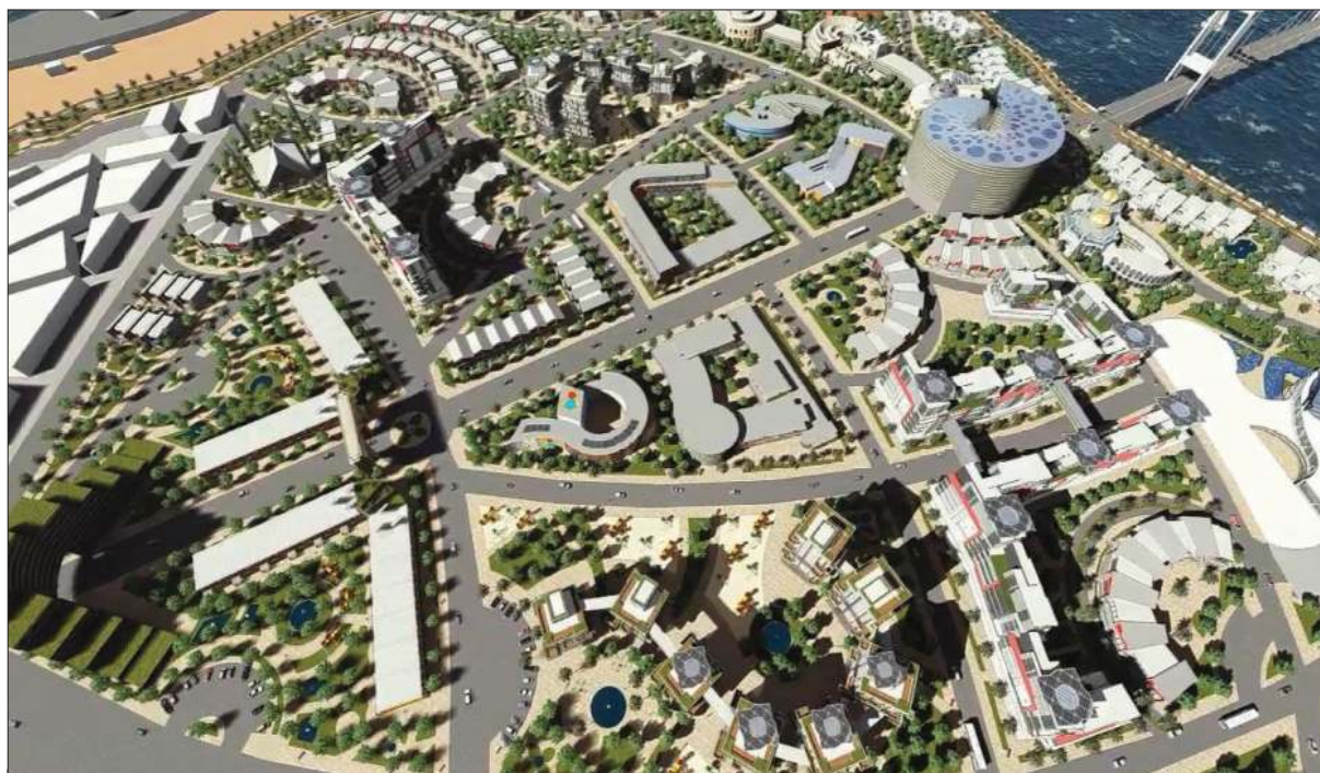
Photo 61: vue d'ensemble du quartier
