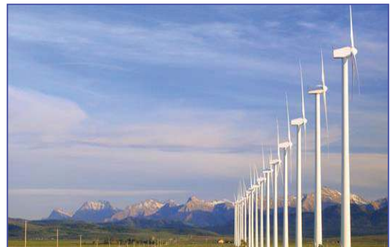
Photo 02 : parc éolienne onshore
