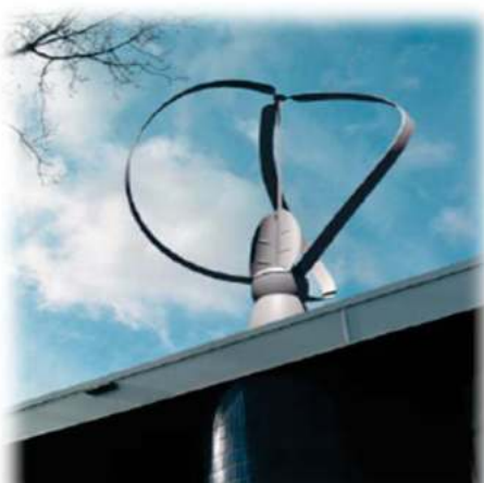
photo04 : éolienne verticale Source : http://www.18h39.fr/articles/une-eolienne-dans-mon-jardin.html
