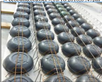
Figure 60: la dalle d'école en plastique recyclé « ecobuild.brussel »,10/10/2018,6 :47pm »
