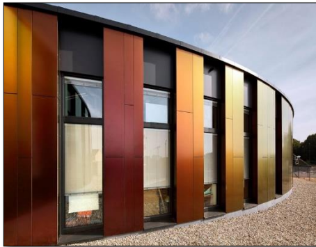
Figure 65: Façade postérieure école trèfle « ecobuild.brussel », 10/10/2019, 6 :47pm
