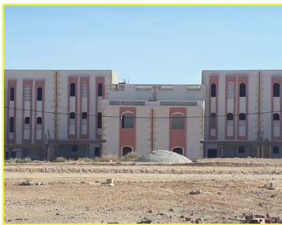
Figure 91: logement LPP Source: « auteurs »
