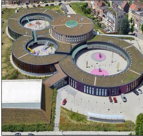
Figure 64: Façade de trèfle « ecobuild.brussel », 10/10/2018, 6 :47pm
