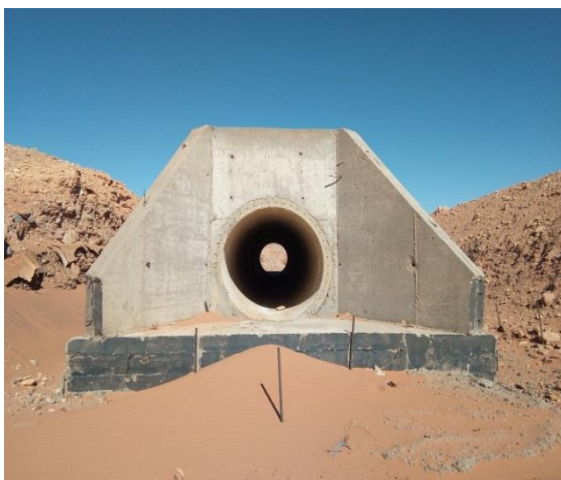
Fig. VII. 4: buse en béton
