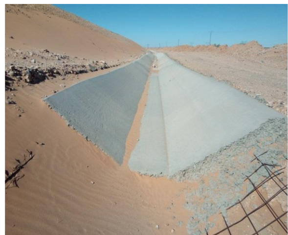
Fig. VII. 5: fossé coulé sur place
