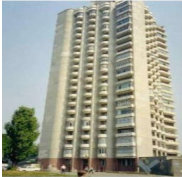
Figure I 17: Premier immeuble en béton géopolymère à Lipetsk, Russie, 1994 [29]
