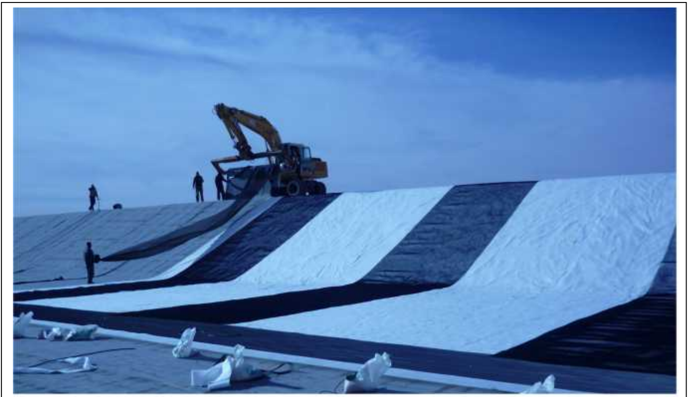
Figure. IV.5:Structure du dispositif d'étanchéité des lagunes
