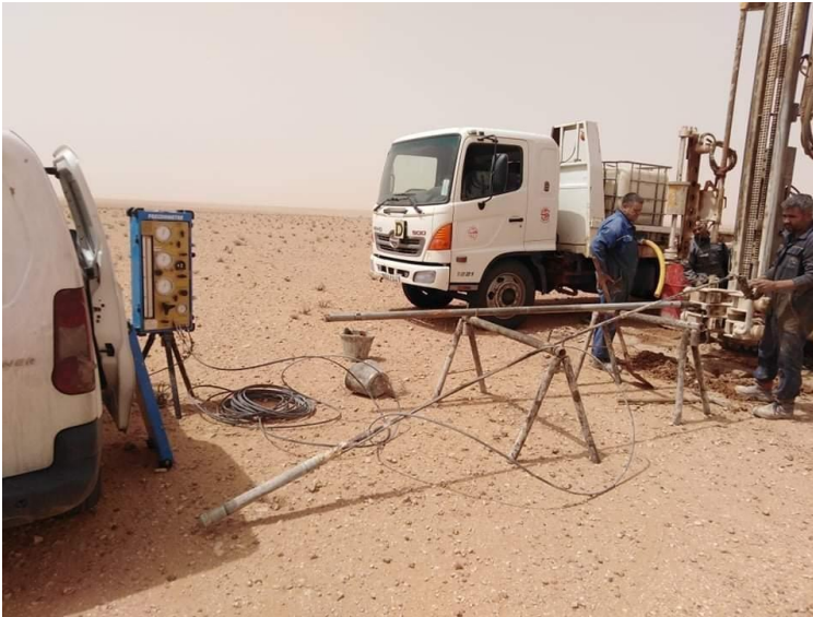
Figure IV:11 L'essai pressiométrique sur chantier
