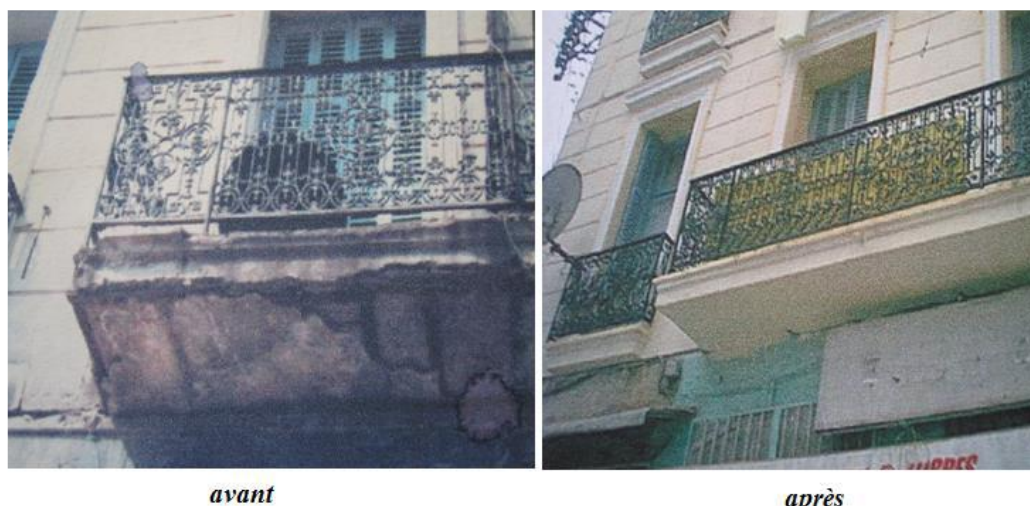
Fig.II. 21: Résultat des travaux de réhabilitation 2003-2010
