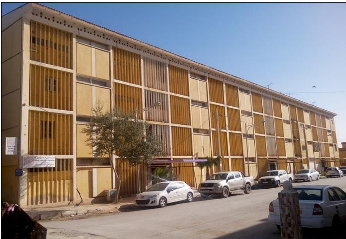
Fig III. 45. Vu sur la façades du bloc 4
