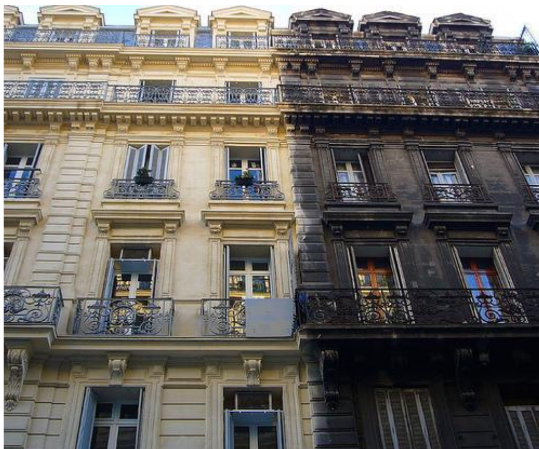
Fig.II. 15 Ravalement de façades la rue de la république à Marseille
