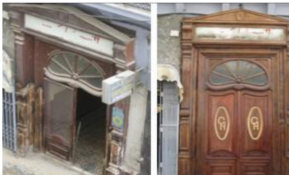
Fig.II. 25: La restauration de la porte d'entrée
