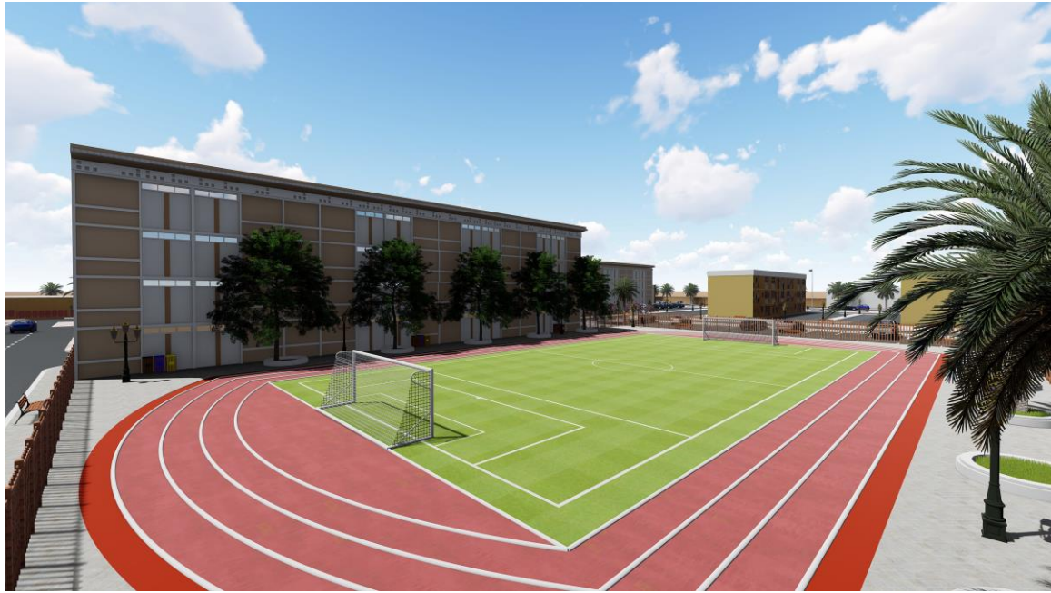
FigIII.B .22.Façade postérieure du Bloc 1
