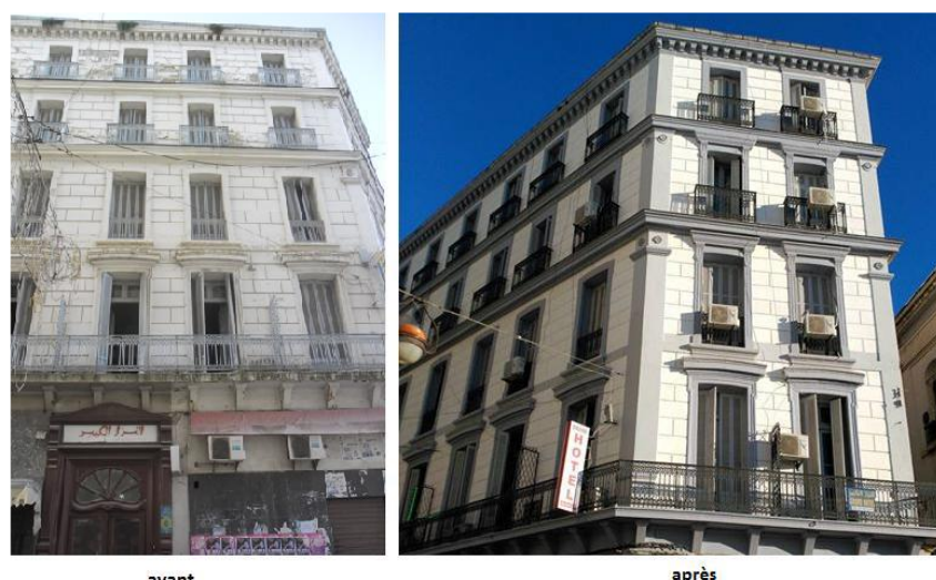
Fig.II. 26: L'immeuble grand hôtel avant/après
