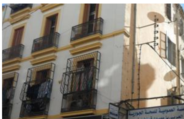
Fig.II. 22: Incohérence marché - travaux réalisés
