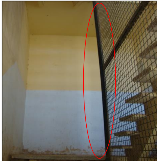
Fig III. 55. Vu sur la cage d'escalier
