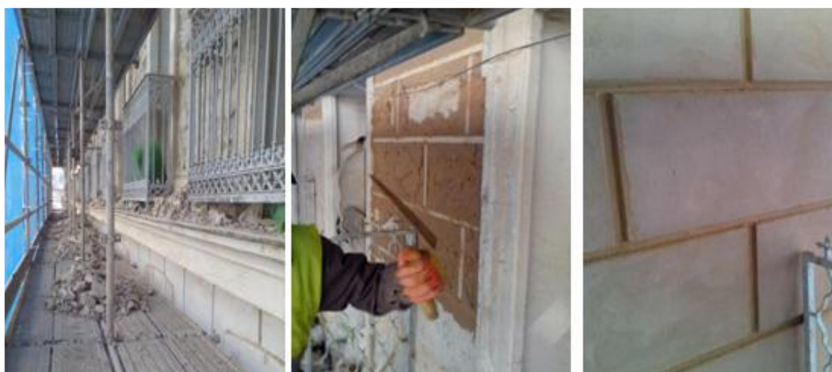
Le décapage du revêtement
