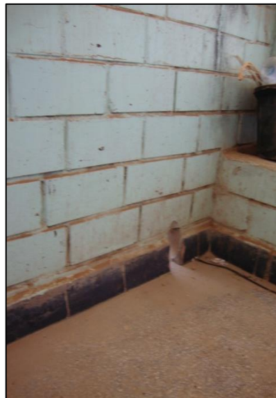
Fig III. 56.La brique pleine dans les loggias
