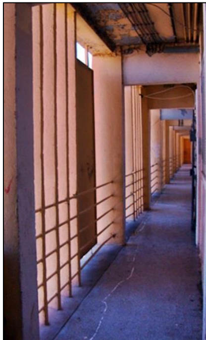
Fig III. 26 . Vu du coursive (Coté droit) Les auteures
