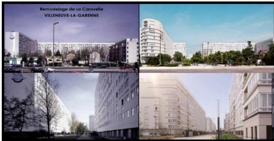
Figure 18 : ; représente les façades après les modifications des façades aveugle ; source , vidéo de Remodeler on Vimeo
