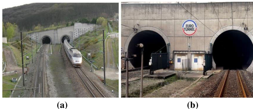
Figure I.16. Différents types de tunnels réalisés en BHP
