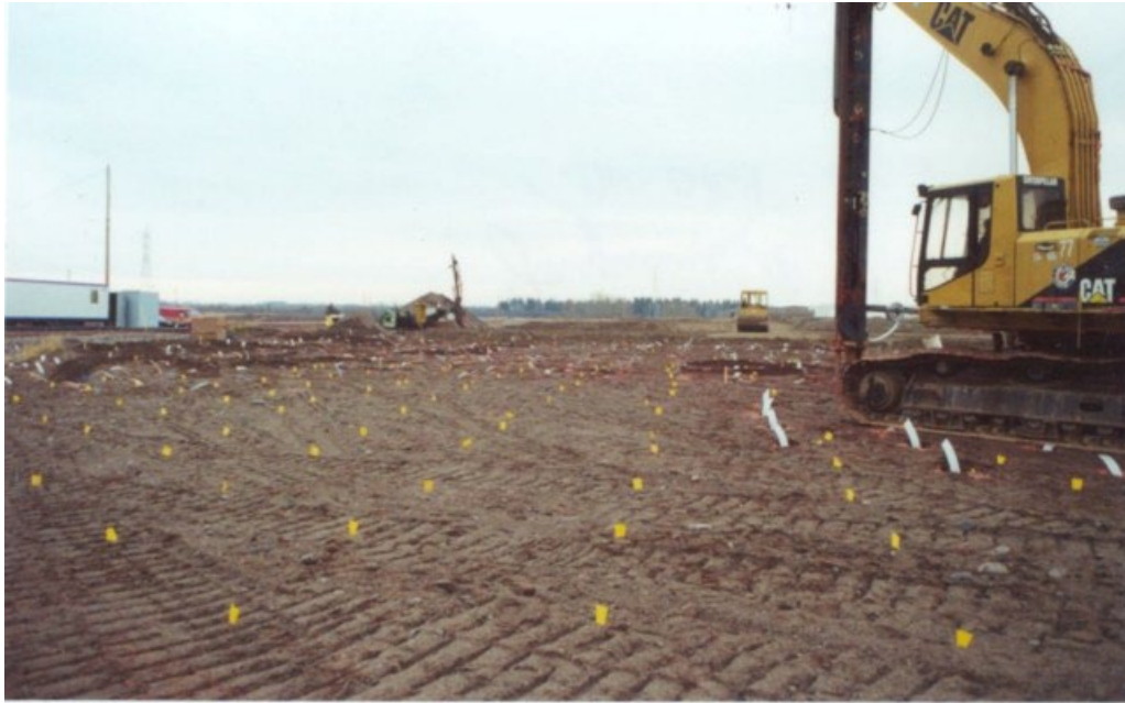
Figure III.2 : Chantier de réalisation des drains verticaux ( Document de Géopac® )
