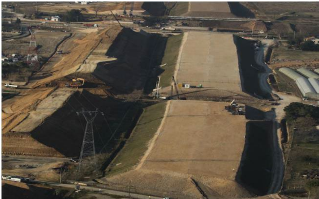
Figure I.11. Remblai de grande hauteur
