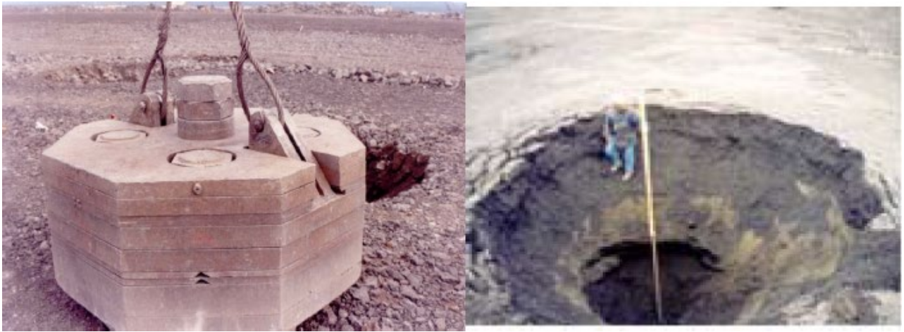
Figure III.4 : Exemple d'un pilon (à gauche) et l'empreinte laissée après sa chute (à droite) (Document de Geopac ®)
