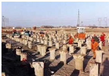
Figure III.8 : Réseau d'inclusions rigides ( Document de Soletanche Bachy® )
