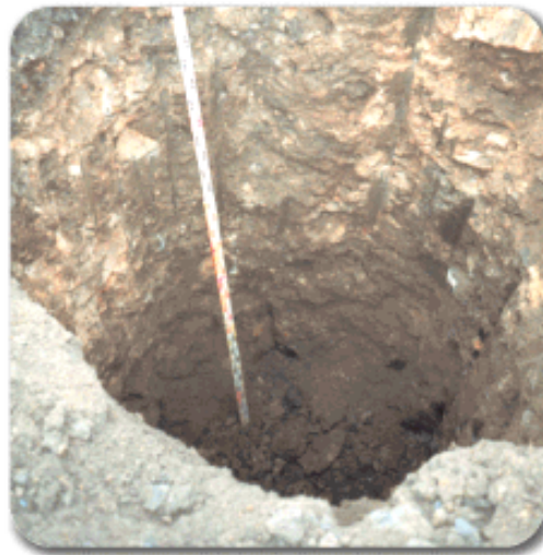
Figure III.14 : Plot ballasté avant remblaiement type ( Document de G.T.S® )
