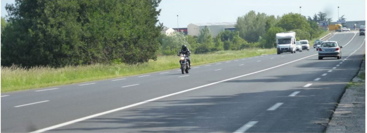
Figure.I.5 : Image d'une route principale [20]
