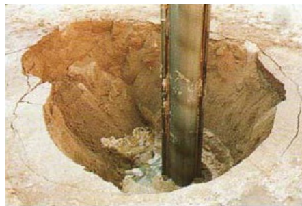
Figure III.5 : Exemple d'un pilon (à gauche) et l'empreinte laissée après sa chute (à droite) (Document de Geopac ®)
