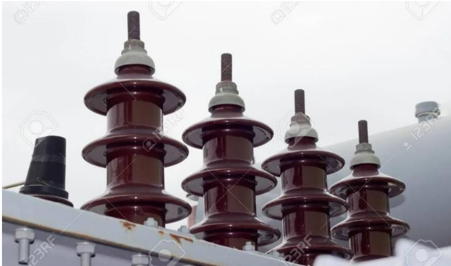
Figure I.5 : Traversées d'un transformateur de puissance.
