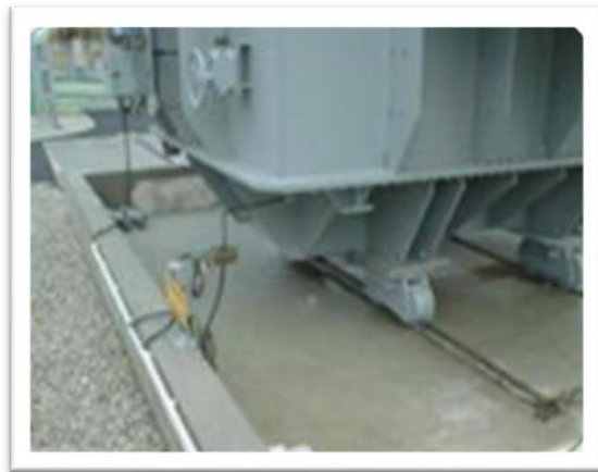
Figure II.5 : Placement de TC tore
