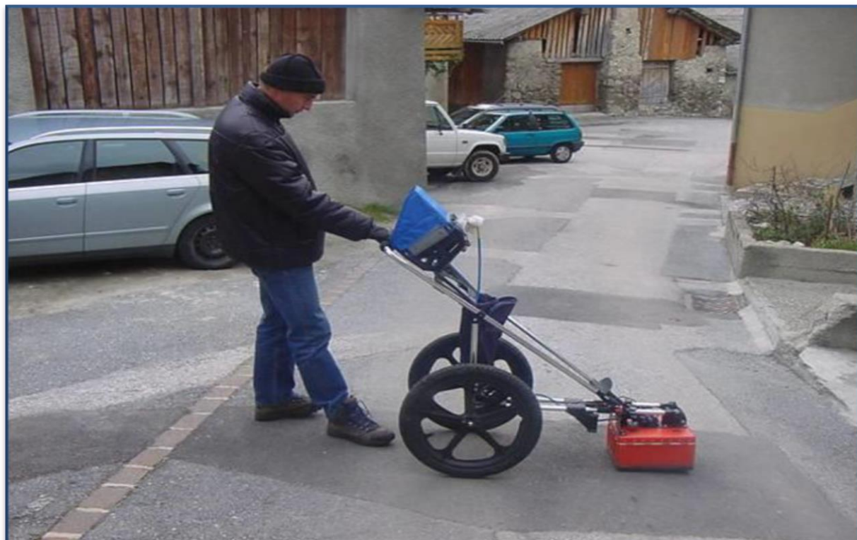
Figure II.6 : Recherche de conduites et cartographie de réseaux enterrés (position, profondeurs) par géoradar. [37]
