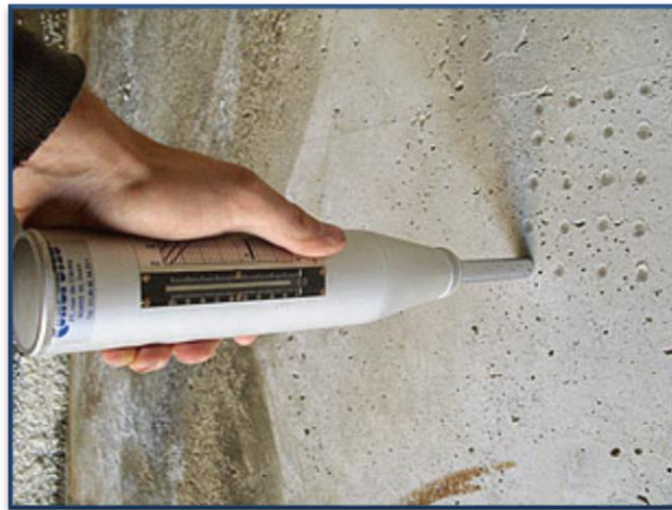
Figure II.2 : Essai de scléromètre (mesure de résistance de béton). [32]
