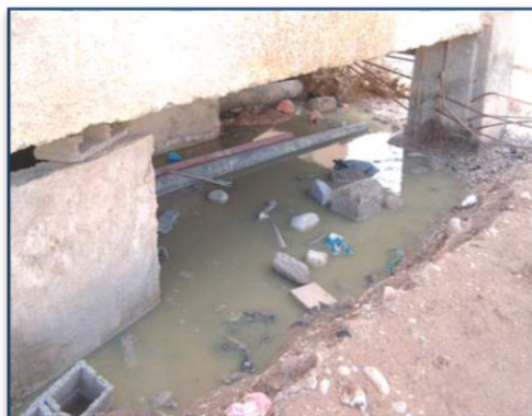
Figure I.27 : Etat des vides sanitaires
