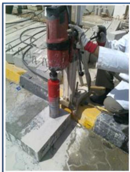
Figure II.8 : Mise en place d'un carottier (Carottage horizontale et vertical). [39]
