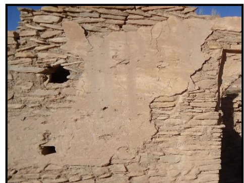
Fig. 99 : Mur en pierre enduit. Ksar Taouiala.
