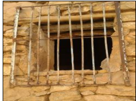
Fig. 82 : Les fenêtres à ksar taouiala.
