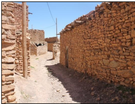
Fig. 65: Rue de ksar taouiala.
