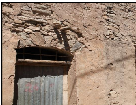
Fig. 98 : Mur en pierre enduit. Ksar Taouiala.
