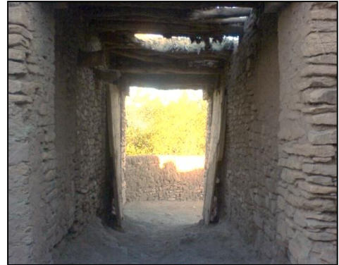
Fig. 42 : La porte d'est du Ksar.
