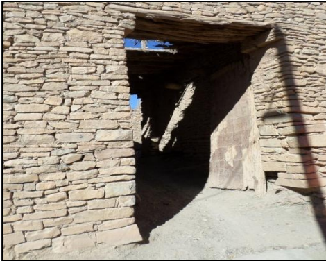
Fig. 41 : La porte d'est du Ksar.
