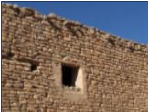
Fig. 81 : Les fenêtres à ksar taouiala.
