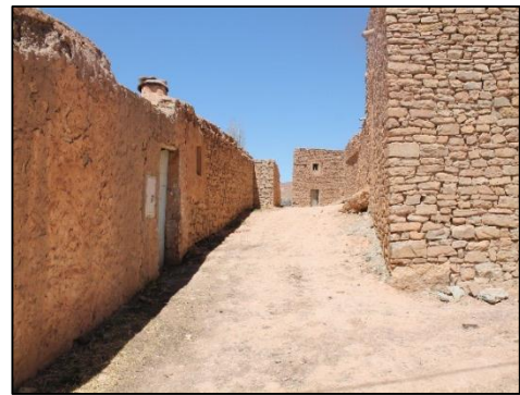
Fig. 66: Rue de ksar taouiala.
