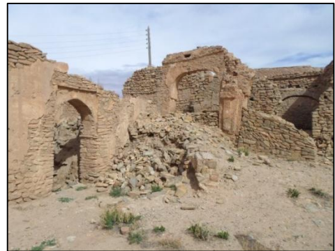
Fig. 48 : Cour intérieure Palais de l'Agha Dine du Ksar.
