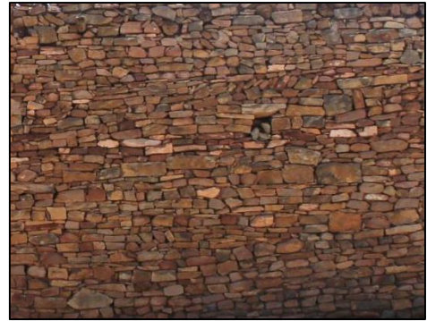
Fig. 97 : Mur illustrant son métérogénéité. Ksar Taouiala.
