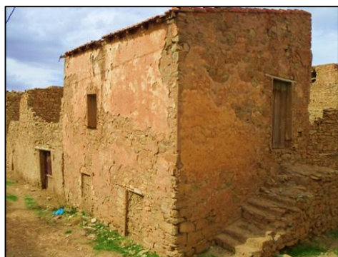
Fig. 89 : Escalier à l'extérieur.
