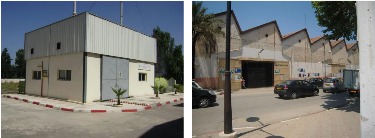
Figure (III.09) : Hangars en Charpente métallique (CGS, 2012)
