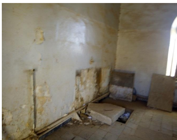
Figure 23 : décellement des murs intérieurs au niveau des Fenêtres . Source : l'Auteur
