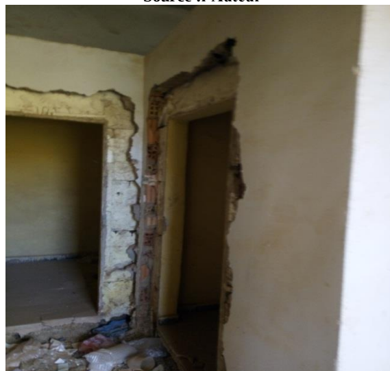
Figure 22: décellement des murs intérieurs. Source : l'Auteur
