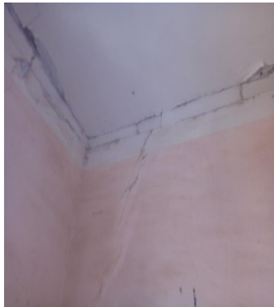
Figure 36: Fissuration superficielle.
