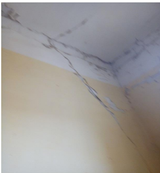
Figure 37: Fissuration superficielle.
