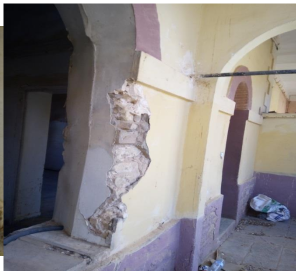
Figure 23 : décellement des murs intérieurs au niveau des Fenêtres . Source : l'Auteur
