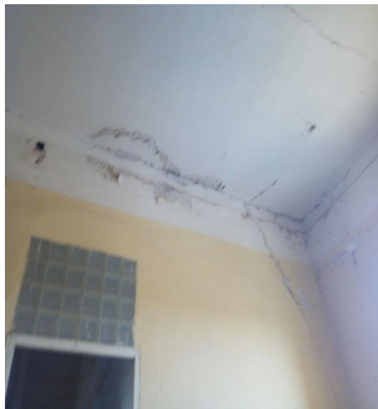
Figure 38: Fissuration superficielle.
