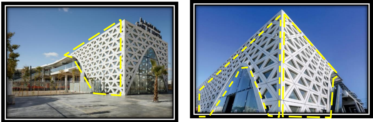
Fig. 25 : la façade réinterprète les codes de l'architecture moucharabieh prédominante dans la ville
