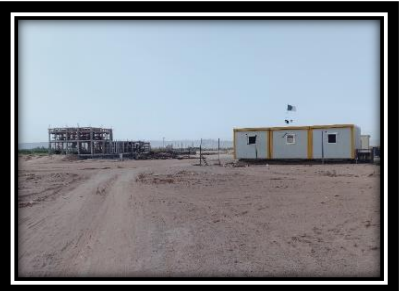
Figure 63 : chantier nouvelle gare férovére Source : photo prise par étudiante 2020
